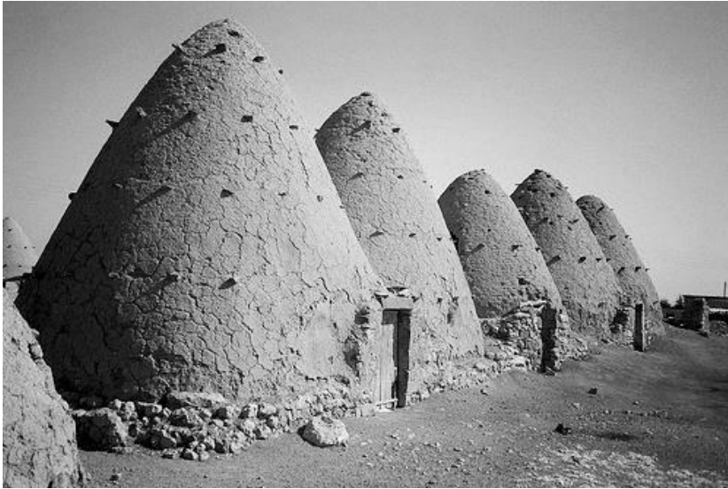
Fig. 1a e 1b Casas beehive (colmeia), na Síria, pensadas para o clima do deserto. As espessas paredes, construídas com tijolos de terra e praticamente sem aberturas, ajudam a controlar a temperatura no interior (em cima e em baixo, à direita).
