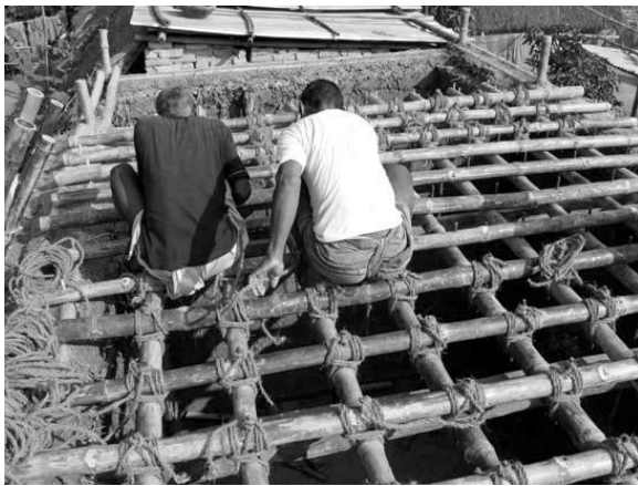
Fig. 10a e 10b Os trabalhos de construção das casas do projecto HOMEmade (Setembro 2007 – Abril 2008), em que colaboraram arquitectos, estudantes e a população local.
