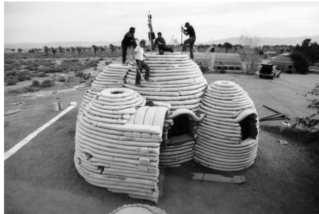
Fig. 10a, 10b, 10c e 10d Processo de construção com Superadobe (em cima). Planta e corte de uma casa em Superadobe (em baixo).
