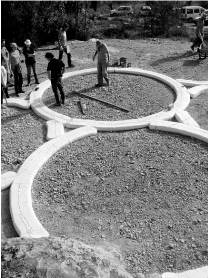
Fig. 10a, 10b, 10c e 10d Processo de construção com Superadobe (em cima). Planta e corte de uma casa em Superadobe (em baixo).
