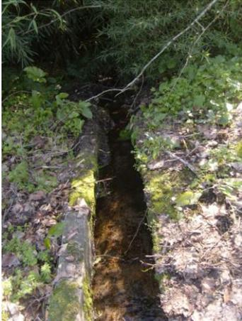
**Figura 33 – Caleira de escoamento, estrutura de condução de água**
