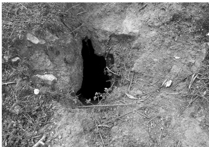
Fig. 23. Mosteiro de S. Bento de Cástris. Túnel de drenagem
