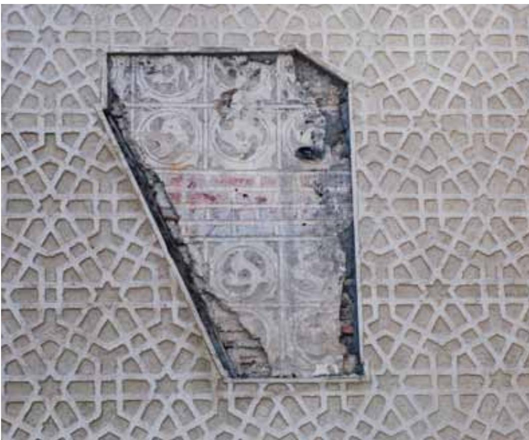
Figura 202. Recuperação de rebocos esgrafitados em Segovia, o padrão do esgrafito novo não é coincidente com o antigo
