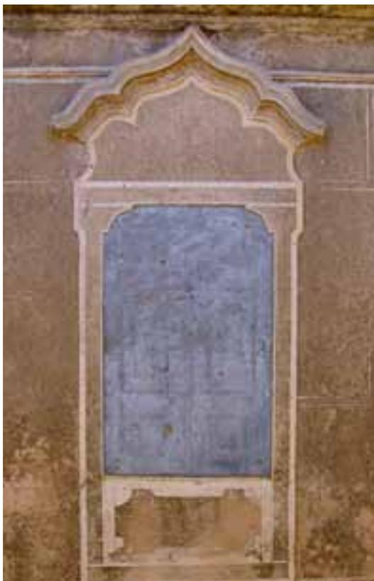
Figura 131. Moldura de vão esgrafitada e revestimento pintado e grafitado para imitar a portada, Castelo de Ouguela
