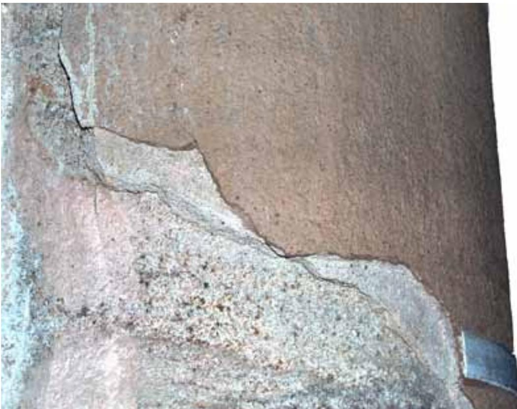
Figura 084. Revestimentos de imitação de alvenaria sobre alvenaria aparelhada, Sé de Évora
