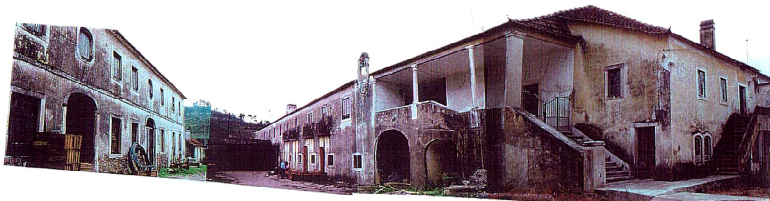
Fig. 5 - Quinta do Vimeiro, vista do interior do conjunto dos edifícios.
