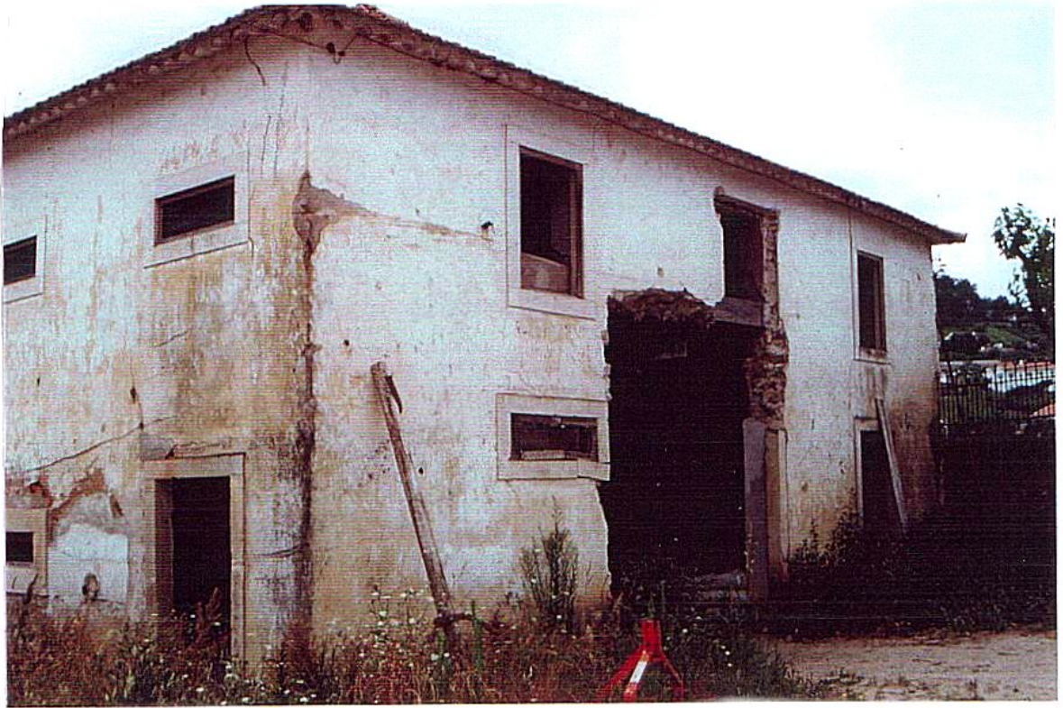
Fig. 8 - Quinta do Vimeiro, vista do edifício A, alçado orientado a Sudeste.
