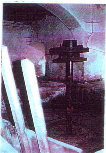
Fig. 15 - Quinta do Vimeiro, vista do tanque onde era pisado o vinho.
