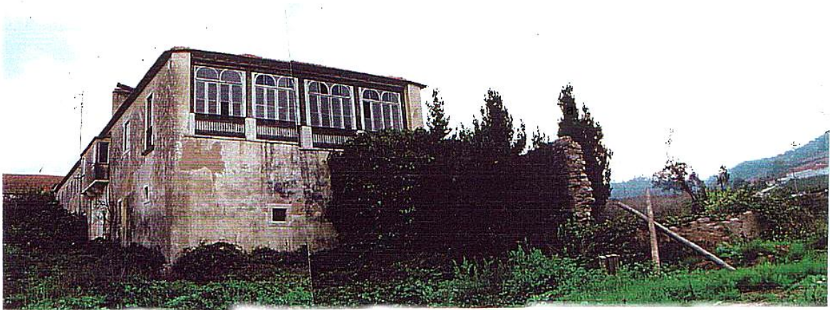
Fig. 23 - Quinta do Vimeiro, vista do alçado tardoz do edifício principal C, orientado a Sudoeste.
