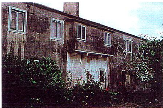
Fig. 24 - Quinta do Vimeiro, vista do alçado lateral, do edifício C, orientado a Noroeste .
