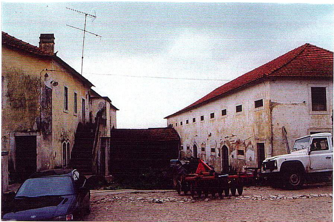
Fig. 7 - Quinta do Vimeiro, vista do edifício B.
