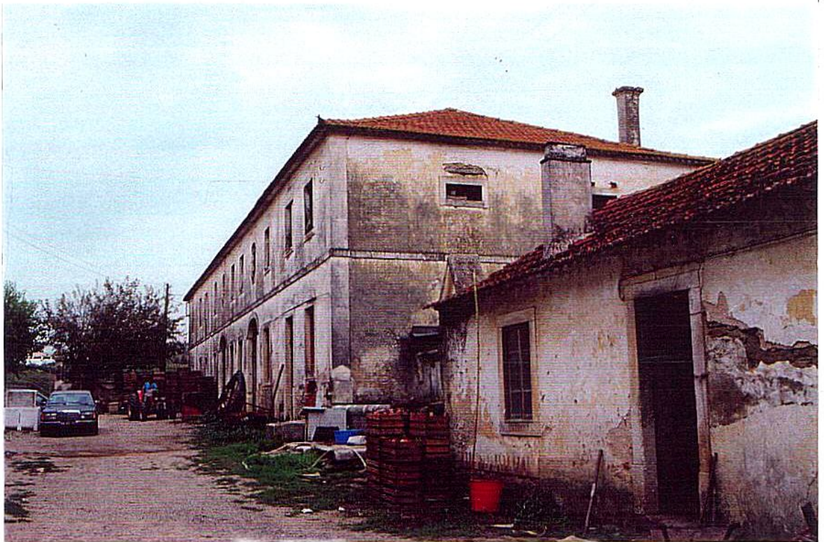
Fig. 9 - Quinta do Vimeiro, vista dos alçados dos edifícios G e E.
