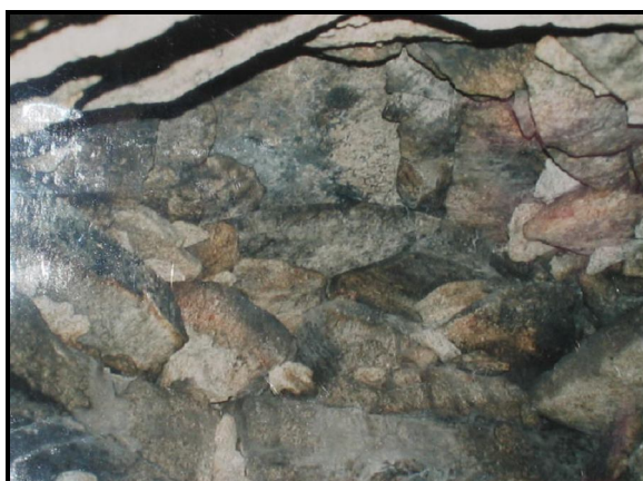
Fig. 5 – Interior de uma banda, mostrando as fiadas de pedra, e a pedra de fecho.
