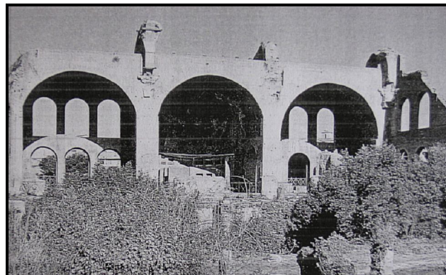
Fig. 13 – Basilica de Maxêncio, construída entre 306 e 312, e dela se podem observar as enormes abóbada de berço com caixotões no seu intradorso.
