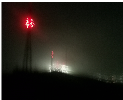
Fig. 8 – Antenas de Comunicação (fotografia de Madalena Dimas).
