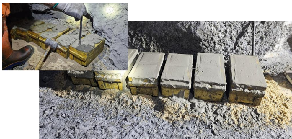
Figura 5.10 - Imagem de moldes após enchimento e pormenor da compactação manual com pilão. A areia na base dos moldes tem o objetivo de nivelar o piso.
