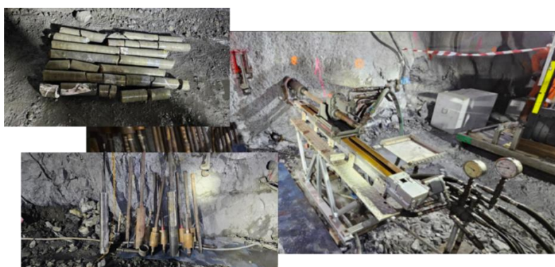
Figura 5.27 - Imagem da sonda de perfuração, coroas de corte, centralizadores de furação e testemunhos dos primeiros metros de furação.
