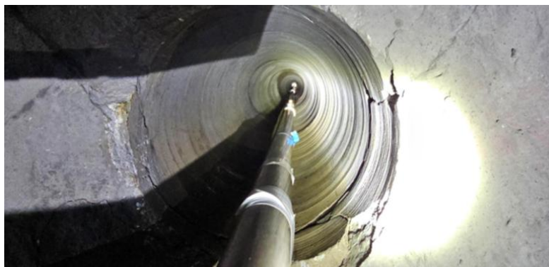
Figura 5.29 - Imagem da vara de colocação e centralização da célula de monitorização.
