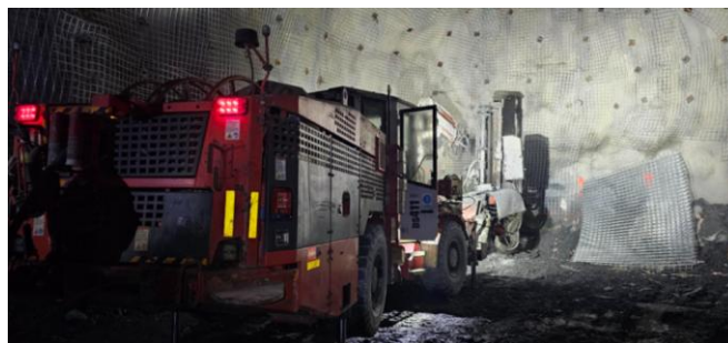
Figura 4.11 - Jumbo para colocação de malha soldada da marca Sandvik.
