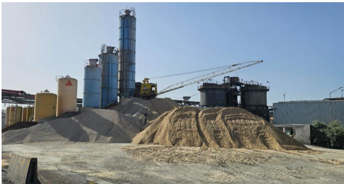
Figura 5.13 - Agregados utilizados para produção de betão projetado localizados em baias de separação na central de produção.
