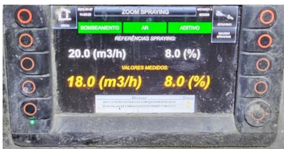
Figura 5.12 - Imagem do monitor do robot de projeção onde se define o caudal de betão em \text{m}^3/\text{h} .
