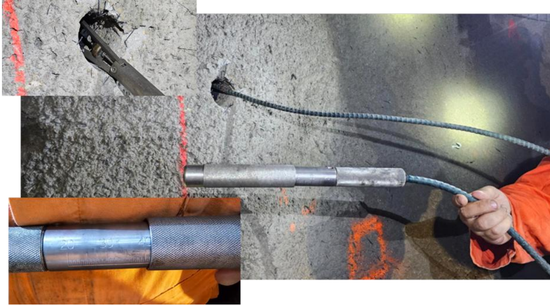
Figura 5.4 - Imagem capturada no momento do ensaio de verificação do diâmetro interno de um furo para parafusos expansivos com pormenor da cabeça medidora e escala milimétrica de leitura.
