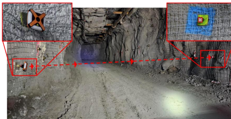
Figura 5.36 - Imagem de sensor de convergência acoplado em ancoragem (lado esquerdo) e de alvo no hasteal oposto (lado direito).
