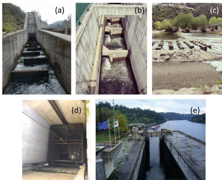
Figura 1. Tipos mais comuns de passagens para peixes abordadas: (a) POD em São Pedro do Sul; (b) VSF em Coimbra; (c) passagem naturalizada (rampa) em Palheiros; (d) ascensor para peixes em Touvedo e (e) eclusa de Borland em Crestuma.
