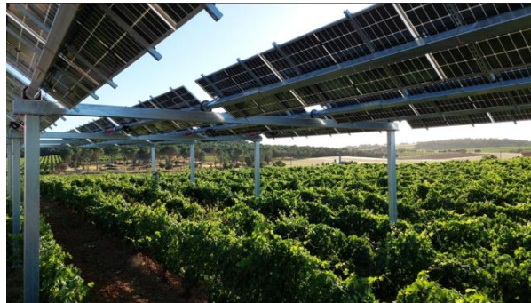
Figura 4: Projeto piloto agrovoltaico da Espanha com uma estrutura elevada sobre uma vinha com potência instalada de 26 kW (Powerfultree, 2025)
