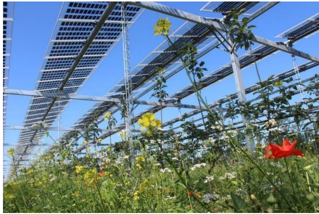
Figura 5: Sistema agrovoltaico com pomares de macieiras (Fraunhofer ISE).
