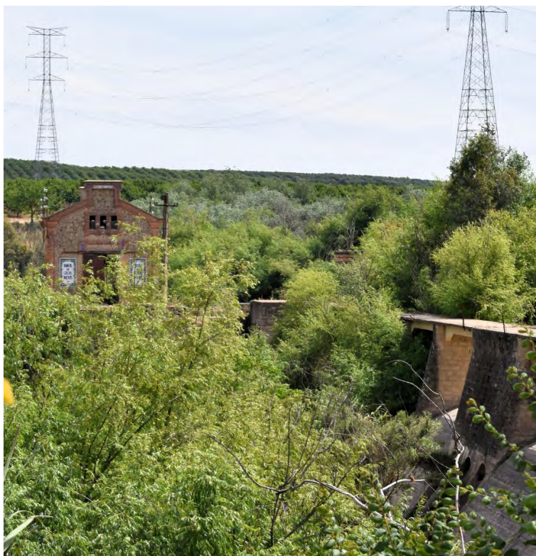
Figura 4. Hidroeléctrica Casas Nuevas, San Julián, Marmolejo (Jaén). Fuente: fotografía de S. Palomares Alarcón (2024).
