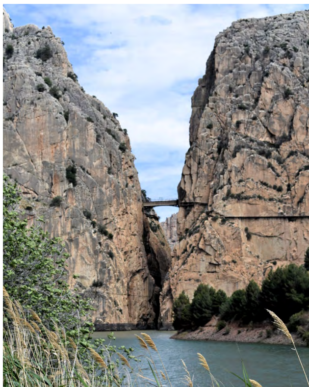
Figura 7. Caminito del Rey (Málaga). Fuente: fotografía de S. Palomares Alarcón (2024).
