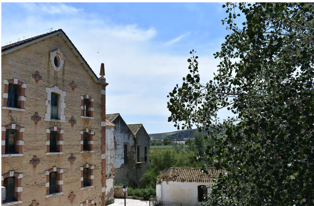
Figura 1. Fábrica de harina San Cristóbal y central hidroeléctrica La Alianza, S. A., Puente Genil (Córdoba).
