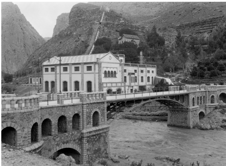
Figura 5. Antigua Central Hidroeléctrica del Chorro (Málaga). Fuente: UDS 19XX0000_AR_2224_0091X - Central Hidroeléctrica del Chorro y puente sobre el río Guadalhorce. Álora, Málaga (España). Fondo Bienvenido-Arenas 02. Archivo Fotográfico Universidad de Málaga.
