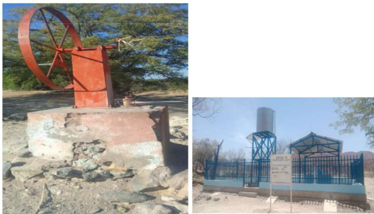
Figura 4. Reabilitação de uma captação em Tchamjafeno
