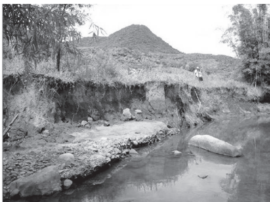
Fig. 4.19. Exemplo de uma margem ravinada devido à exposição à corrente de cheia sem protecção de vegetação marginal (imagem cedida por H. P. Rauch)
