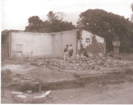
Visita técnica dos arquitectos às obras em curso - San Pedro, Trinidad, Cuba
