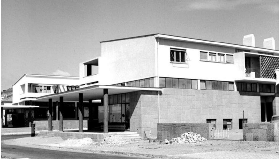
Figura 3 – Centro Comercial e Habitacional do Restelo em Lisboa (1956) Fonte: Monumentos - [Consult. 27 jun. 2023]. Disponível em WWW:<URL: http://www.monumentos.gov.pt/Site/APP_PagesUser/SIPA.aspx?id=16560 >.
