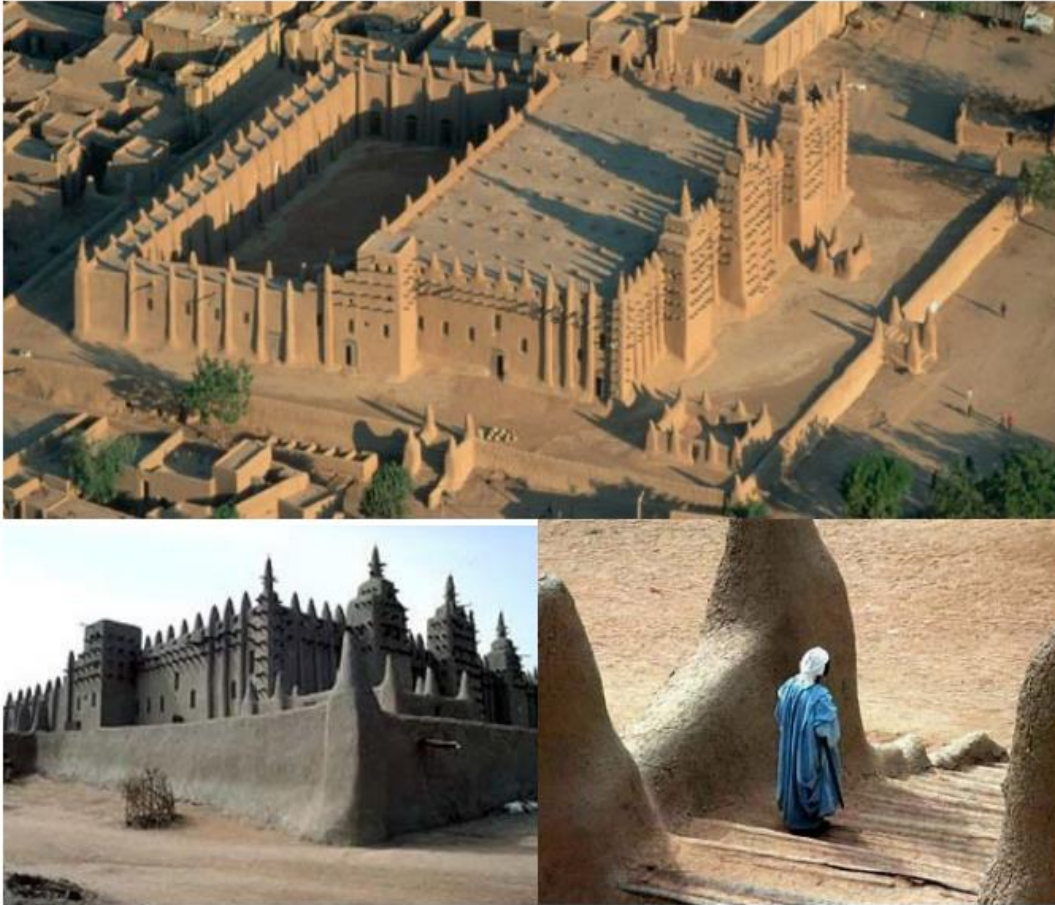
Figura 2-10: A Grande Mesquita de Djenné, atualmente a maior obra em terra crua, construída em adobe, Mali (1280 d.C.) (África Ocidental). (Jahn, 2005; Williams e Kniveton, 2011, citado em Wachilala, 2018).
