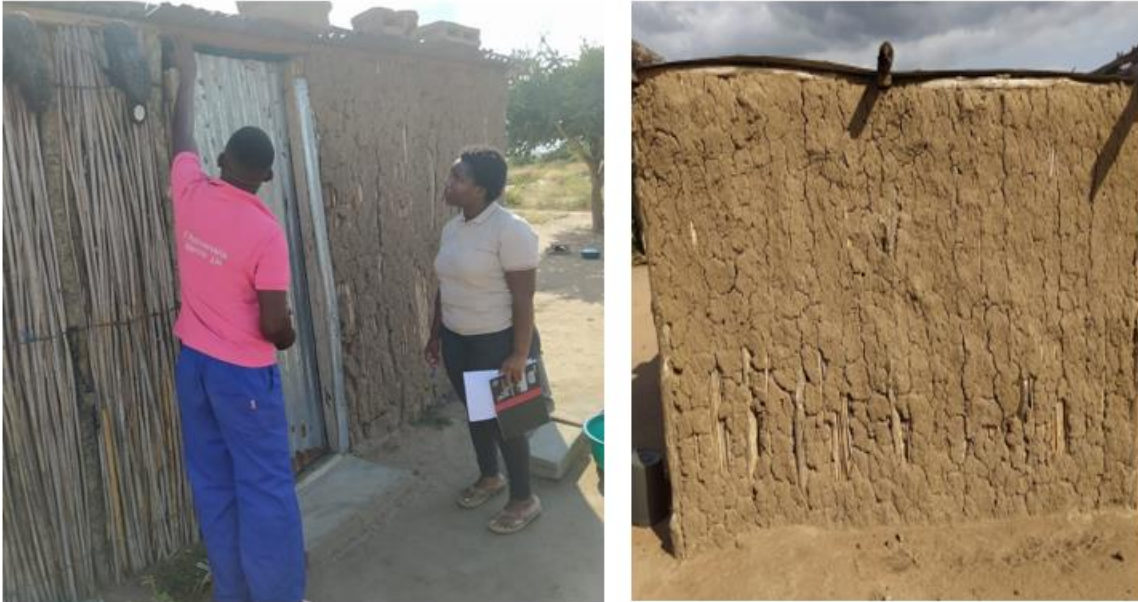
Figura 2-14: Uso do solo como material de cobertura da estrutura feita de caniço e bambu. Fonte: Tárícia Novele, 2023.
