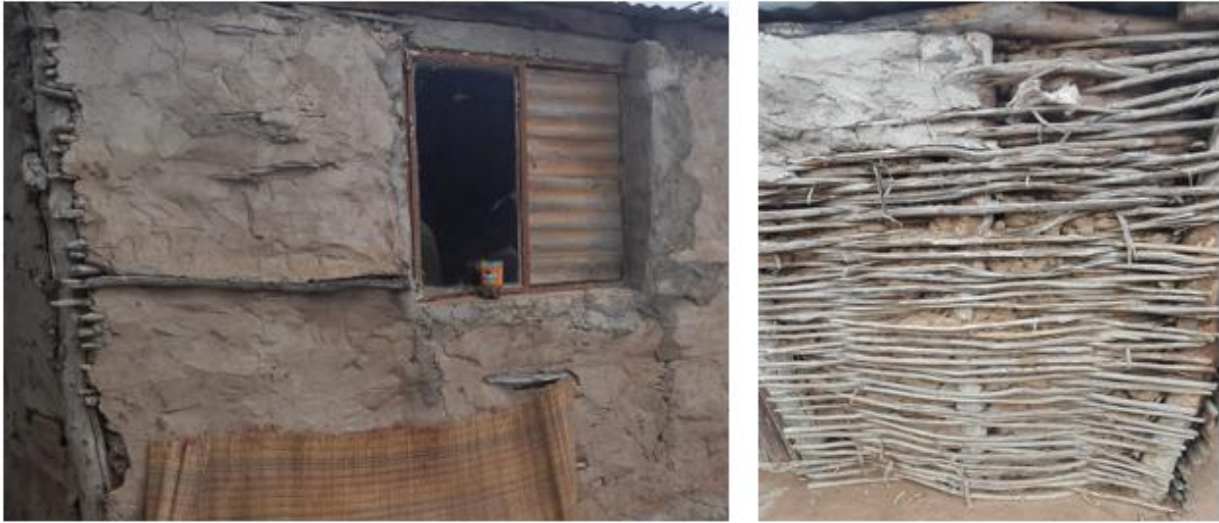
Figura 2-15: Construção de pau-a-pique revestida de cimento. Fonte: Tárícia Novele, 2023.
