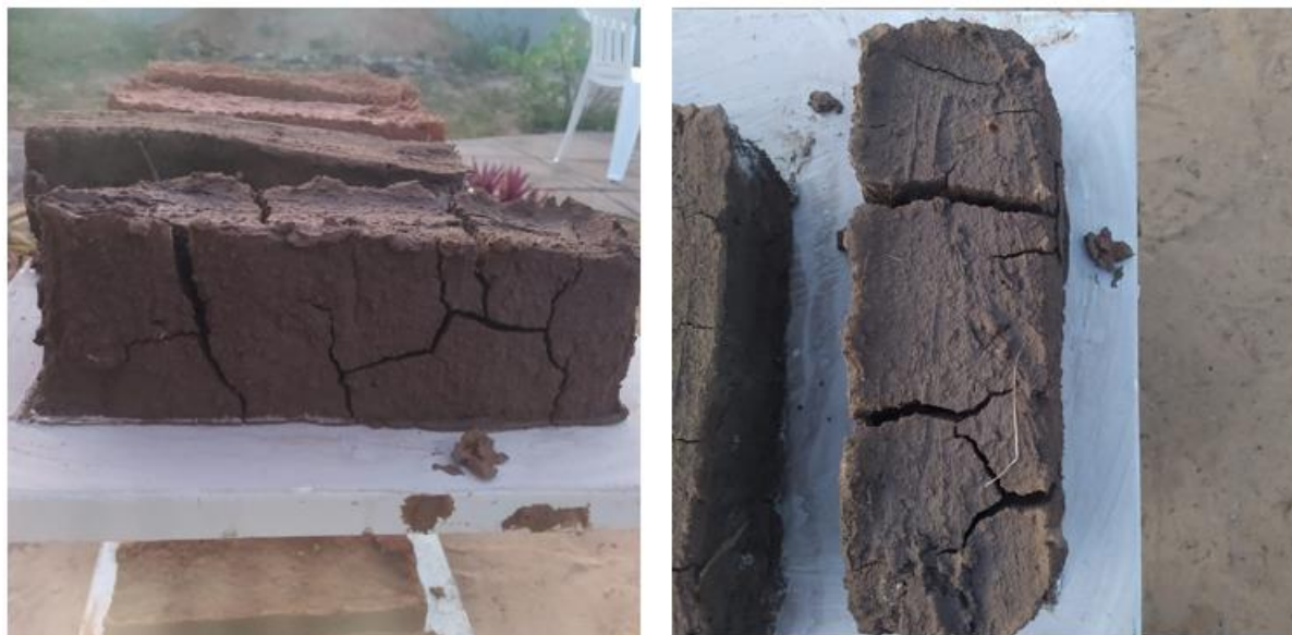
Figura 5-6: Adobe deformado antes do tempo de cura.
