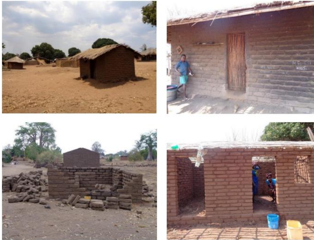
Figura 2-11: Construções em terra feitas de adobe, típicas das zonas centro e norte de Moçambique. Fonte: Ribeiro, 2015
