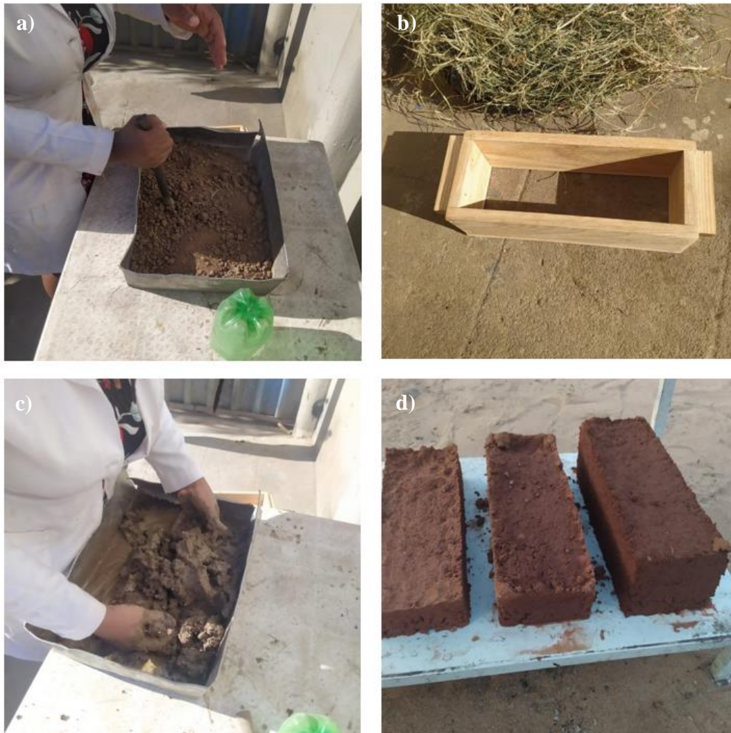
Figura 4-15: Processo de produção de adobes: a) Preparação do solo; b) Molde de madeira e material de reforço utilizado; c) Mistura do material; d) Adobes expostos ao sol para secar.
