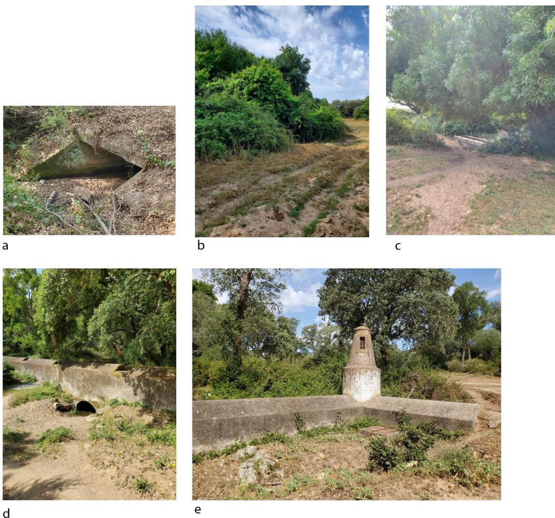
Figura 22 - a) local de passagem de águas sob ponte; b) galeria ripícola com aceiro; c) bebedouro instalado sobre a linha de água/nascente; d) pisoteio junto á passagem de água sob aqueduto; e) início da estrutura superficial do Aqueduto da Água de Prata.
