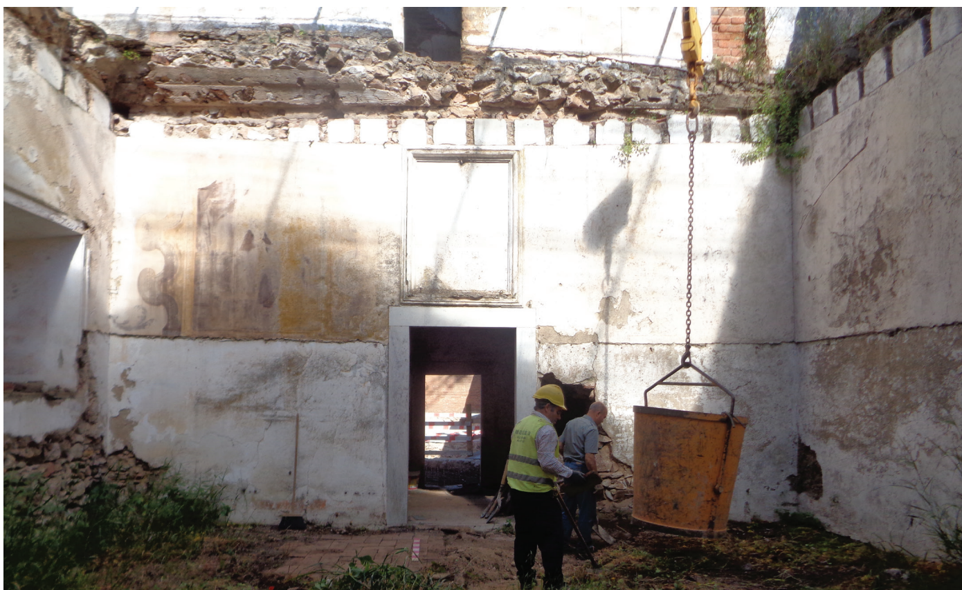
Figura 4.7 - A casa do Coro Alto, na altura em que começou a ser desimpedida de entulhos, vendo-se a linha no reboco que delimitava o desaparecido cadeiral. Ao centro, no moldurado sobre a porta, estava uma pintura representando S. Jerónimo. Janeiro de 2018.
