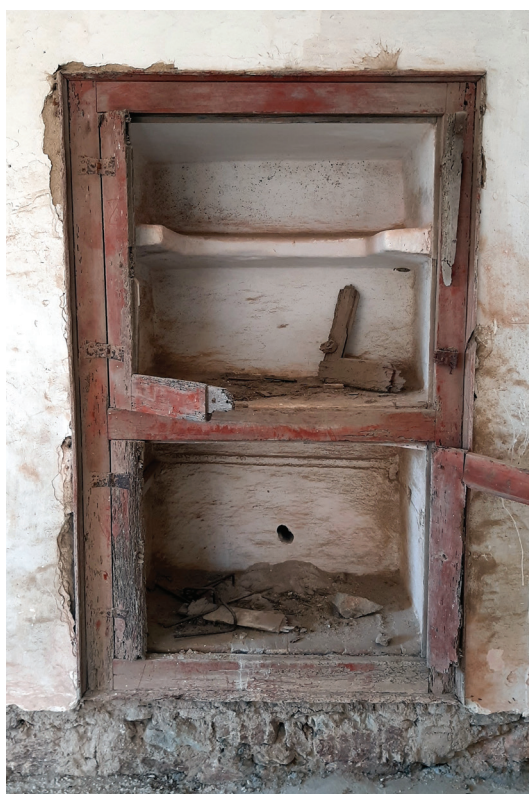
Figura 6.51 - Armário-cantareira, perto da pia ou lavatório do segundo piso da Torre da Prioresa . Outubro de 2020.
