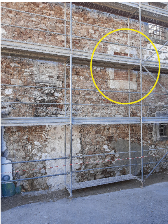
Figura 3.6 - O pano de tijolo (U.C.106) que fechou, nos finais da primeira metade do séc. XVI, um vão de janela conversadeira que terá pertencido ao edifício que precedeu o Convento, na altura em que foi posto a descoberto.
