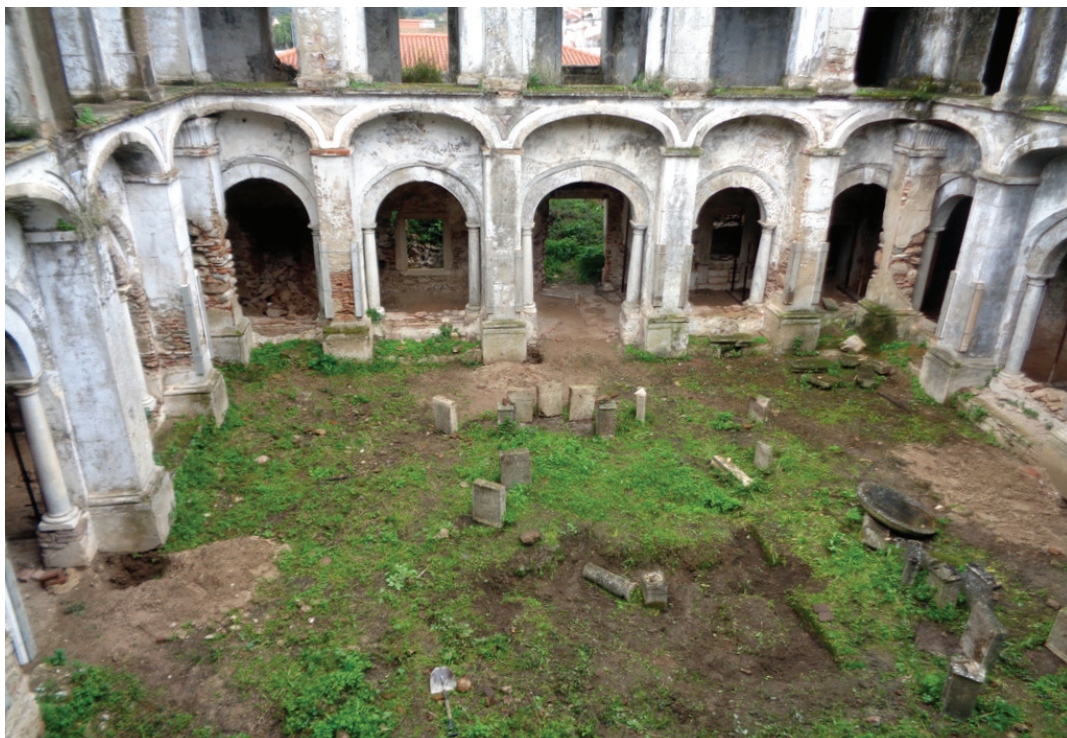
Figura 5.3 - Vista parcial do pátio central do Convento do Bom Jesus de Viana do Alentejo, em Janeiro de 2018, quando se iniciou a intervenção. Ao centro e em baixo pode ver-se o negativo deixado pelo arranque da fonte central. Em volta dispersam-se alguns elementos da sua cantaria. Março de 2018
