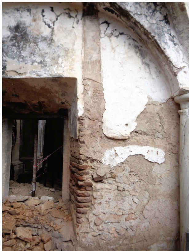
Figura 6.4 - Confessionário Novo . Vestígios do local onde se ligava uma das paredes construídas para seccionar a sala 1.16. Julho de 2018.
