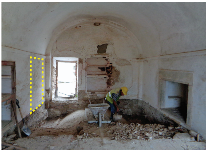
Figura 6.16 - Interior do primeiro piso da Torre da Priorosa. O traçado amarelo localiza um antigo vão de porta, encontrado entaipado, que ligava às escadas que conduzem ao segundo piso. A porta ao fundo acedia à ala norte do Dormitório Velho. Julho de 2018
