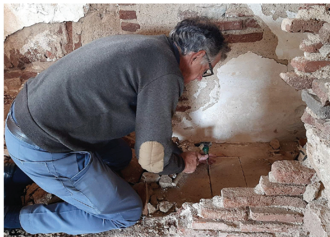
Figura 6.27 - Iniciando-se os trabalhos de levantamento do pavimento da buraca do arranque das escadas do 2.ª para o 3.ª andar da Torre da Prioresa, sob o qual se encontrou um oculto lance de escadas mais antigo. Novembro de 2020.
