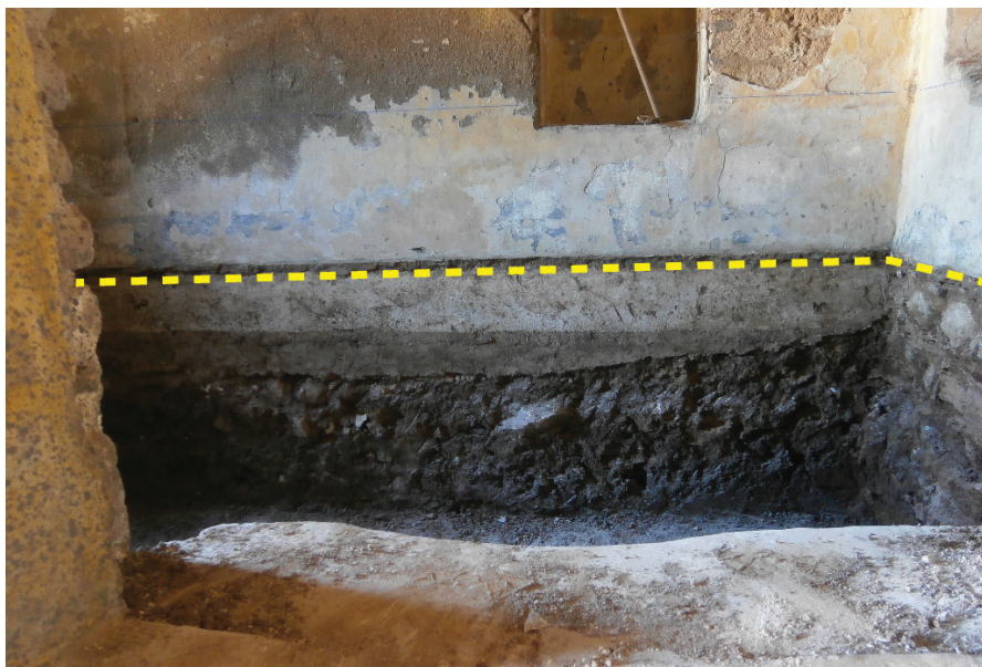
Figura 6.33 - Sala 1.20 (uma das divisões da antiga hospedaria da Casa), indicando a linha amarela a cota do piso actual, cerca de 50cm acima da cota do pavimento primitivo. Março de 2019.
