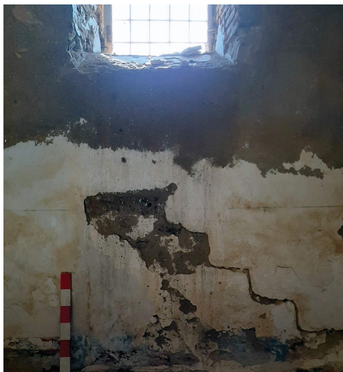
Figura 6.11 - Negativo das desaparecidas escadas de acesso à grade, na Casa da Grade Velha. Novembro de 2020.
