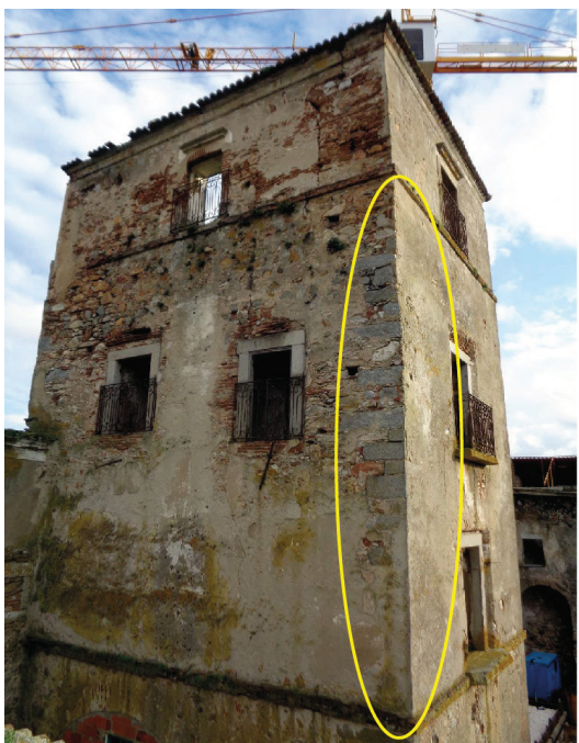
Figura 6.19 - O cunhal, em granito, do canto NO da Torre da Priora abrange todo o 1.º, 2.º e a maior parte do 3.º piso. Março de 2018.
