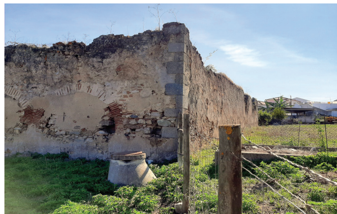
Figuras 5.14 e 5.15 - Exteriores da Cerca Velha, na Travessa de Trásmosteiro (à esquerda) e da Cerca Nova, junto ao cunhal granítico NO, vendo-se os respectivos arcos estruturais. Outrora os muros encontravam-se totalmente rebocados.
