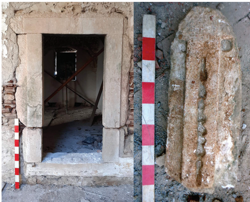
Figura 6.5 - Confessionário Novo: Janela transformado em porta, para lhe dar acesso. A soleira apresenta os orifícios da grade. Novembro de 2020.
