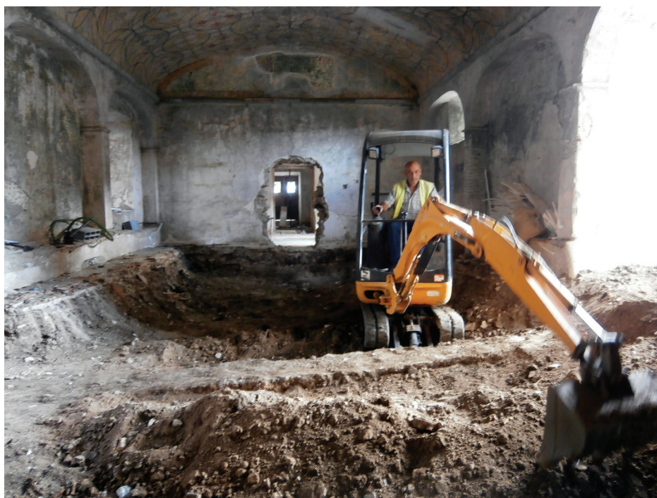
Figura 6.48 - Protegida por fortes argamassas de cal, a conduta de abastecimento da fonte do Pátio central atravessa a casa do Refeitório, vinda do pátio da Porta do Carro (à esquerda), tendo sido posta a descoberto aquando dos trabalhos de rebaixamento da cota do seu pavimento. Note-se a acentuada pendente do troço. Setembro de 2021.
