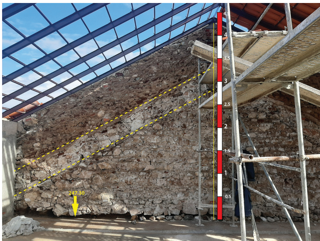
Figura 6.42 - Casa por cima do Coro Alto, onde se terão acomodado algumas das criadas da Casa. Na empena poente da igreja são visíveis os sucessivos acrescentamentos, assinalados a tracejado, que tiveram como objectivo elevar o pé direito do templo. Outubro de 2020.
