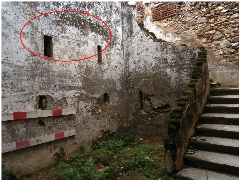
Figura 5.7 - Casa das Escadas e inscrição esgrafitada fazendo alusão á bíblica Escada de Jacob:
