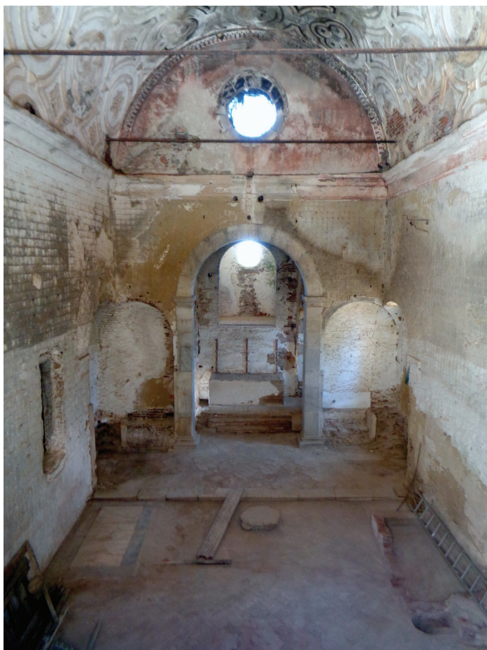
Figura 5.8 - Vista parcial da Igreja, tirada a partir do Coro Alto. É observável parte da decoração da abóbada de berço e, na parede da esquerda, a trama em negativo deixada pelo arranque do revestimento azulejar. Ainda à esquerda e em baixo é visível o vão que dava acesso ao desaparecido púlpito em pedra. Julho de 2018.
