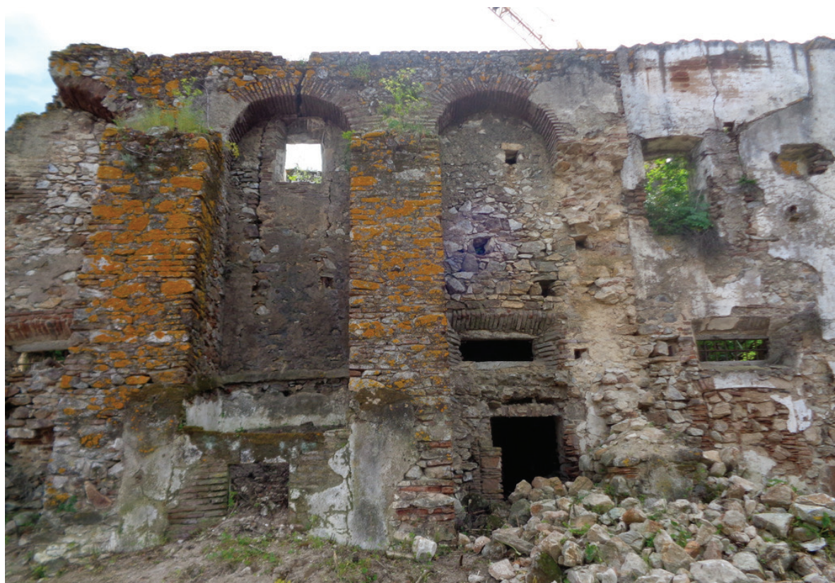
Figura 5.9 - Estrutura arcada adossada ao alçado norte, onde esteve instalada a principal cozinha da Casa. Maio de 2018.
