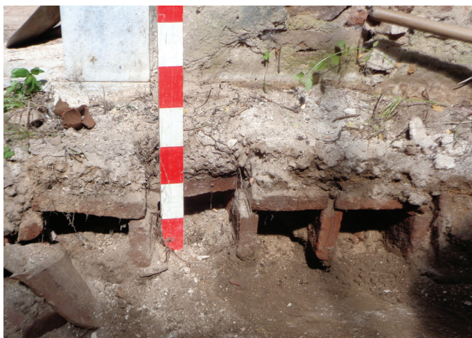
Figura 6.40 - Estrutura de ventilação obrada em tijolo burro, encontrada já muito destruída sob o pavimento cerâmico do Coro Alto. Maio de 2018.
