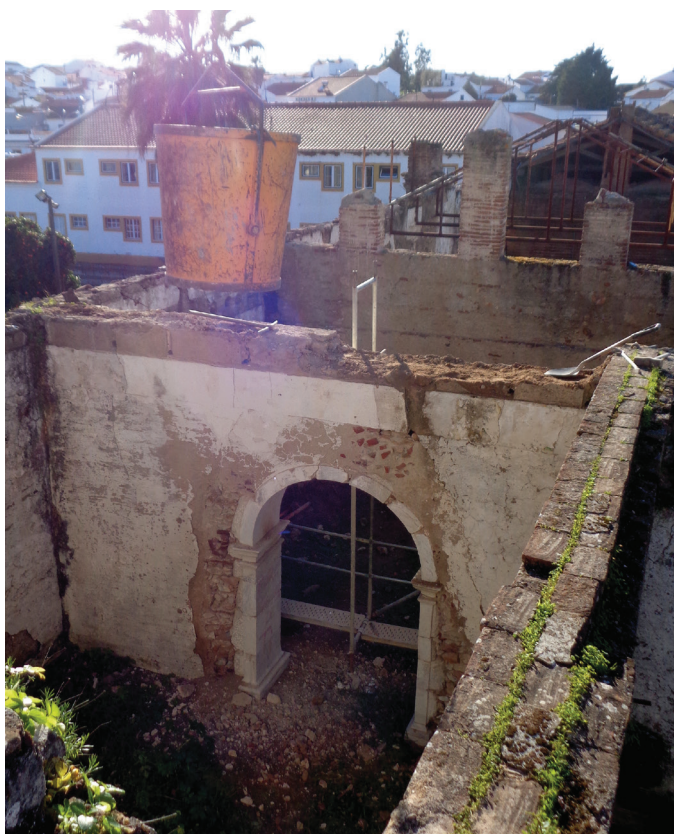
Figura 5.20 -Desmontagem do arco que dava acesso à ala meridional do Dormitório Velho e, daí, ao Dormitório Novo construído já nos alvares do século XVIII. Ao lado, o respectivo. Março de 2018.
