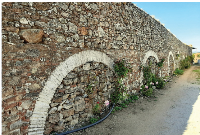
Figuras 5.14 e 5.15 - Exteriores da Cerca Velha, na Travessa de Trásmosteiro (à esquerda) e da Cerca Nova, junto ao cunhal granítico NO, vendo-se os respectivos arcos estruturais. Outrora os muros encontravam-se totalmente rebocados.
