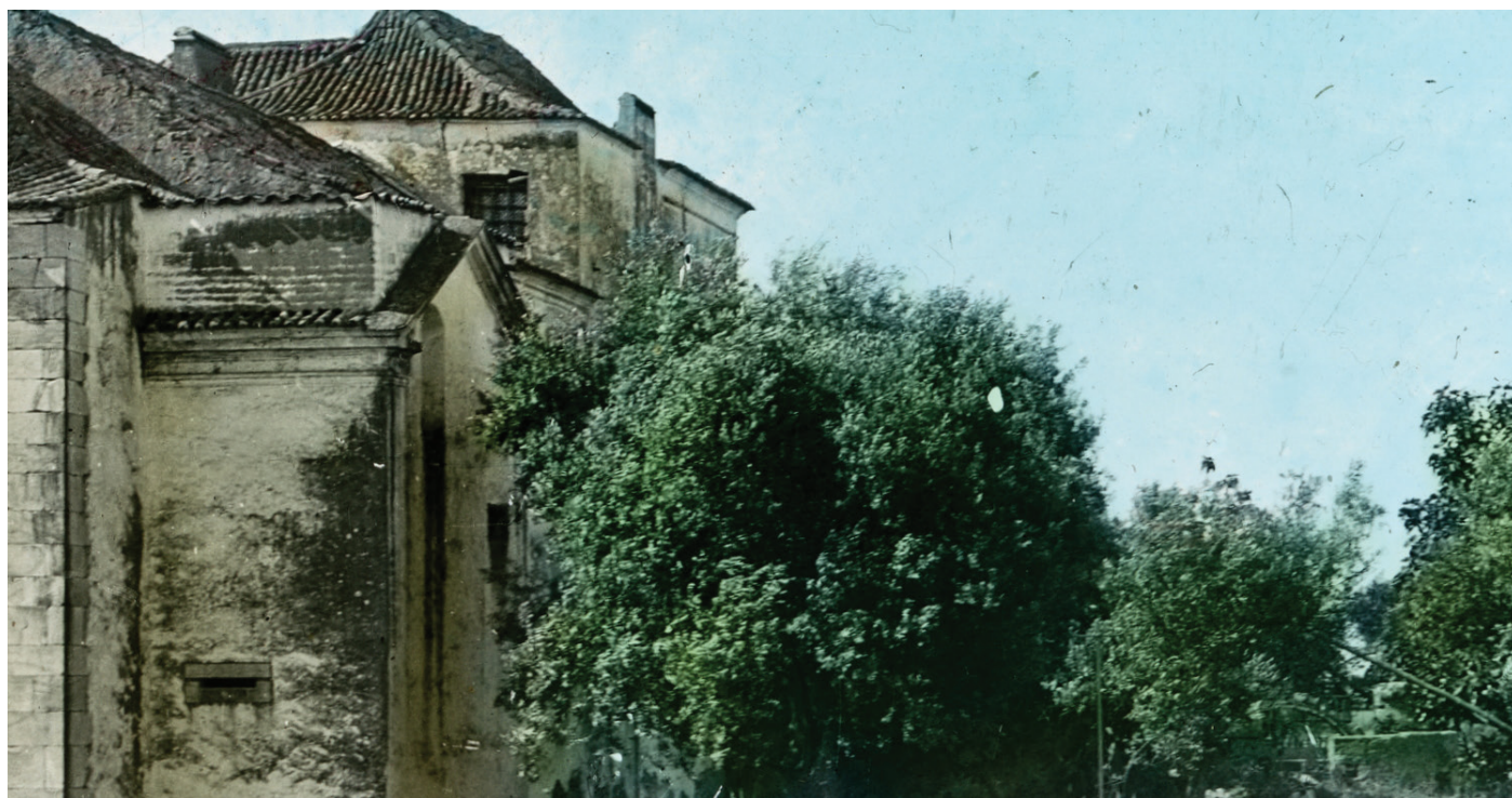
Figura 3.2 - Alçado lateral nascente do Convento do Bom Jesus de Viana do Alentejo. A construção em segundo plano, que cavalgava as antigas sacristias, desapareceu quase por completo. Note-se, em cima e quase no centro, a chaminé que poderia ter servido a cozinha das enfermarias. Uma outra chaminé, no canto esquerdo superior, poderá ter sido a das instalações das noviças. Pormenor de fotografia de Viriato Campos, circa 1925, colecção do autor.
