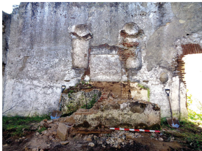
Figura 5.24 - Casa da Enfermaria, no primeiro piso, vendo-se os vestígios do altar em alvenaria de tijolo adossado à parede nascente, assim como os dois nichos superiores e a pequena pia de água benta, à direita, junto ao vão de porta. Maio de 2018.
