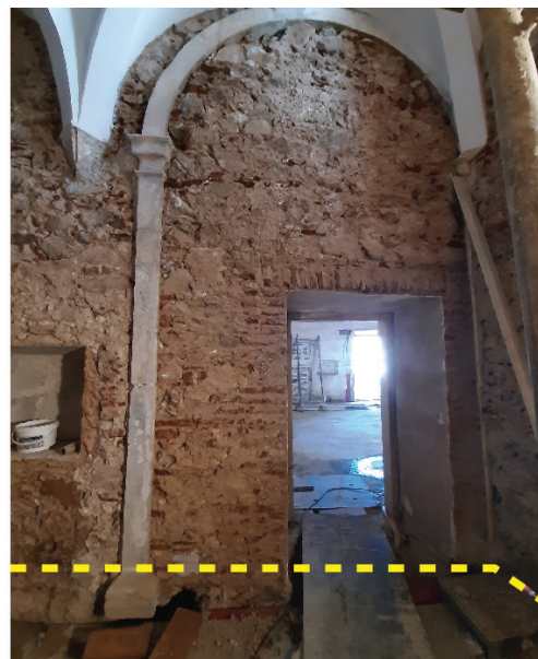
Figura 6.34 - Sala 1.06, onde pernoitariam as madres porteiras, vendo-se o arco em pedra que se encontrou em parte entaipado. A linha amarela demarca a cota do pavimento actual. Julho de 2022.
