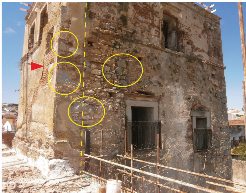
Figura 6.20 - Alçado norte da Torre da Priora. Os círculos amarelos assinalam os silhares graníticos do cunhal NE, que já não foram repostos no lugar aquando do alargamento, para nascente, da torre - assinalado pela linha tracejada amarela. A seta vermelha localiza parte da alvenaria em tijolo, no lado nascente, com que foi obrado o dito alargamento. Junho de 2019.
