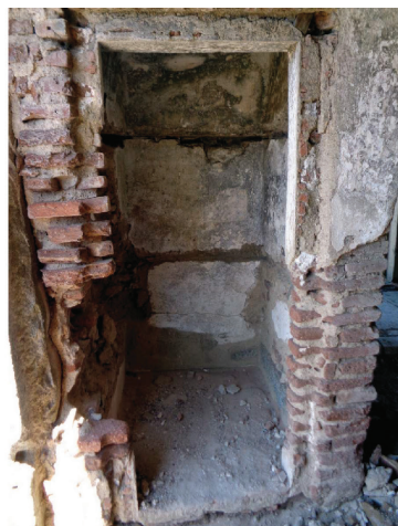
Figura 6.26 - Buraca aproveitada para cómodo de arrumos, com prateleiras, na Torre da Prioresa. Julho de 2018.
