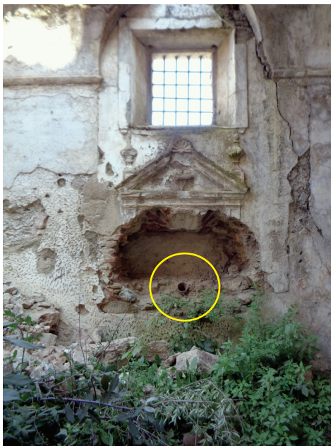
Figura 6.49 - Negativo deixado pelo arranque do lavatório em pedra da Sacristia de Fora . O círculo amarelo localiza a conduta de saída da água. Julho de 2018.
