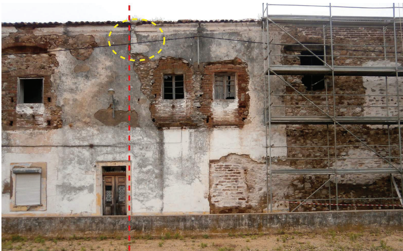
Figura 6.22 - Alçado principal do Convento do Bom Jesus. A linha vermelha assinala o local de ligação entre a zona mais antiga do complexo, à direita e a nova. O círculo amarelo indica os vestígios do primitivo cunhal em mármore que limitava, pelo lado SO, o edifício antes do alargamento de inícios do séc. XVIII. Junho de 2020.
