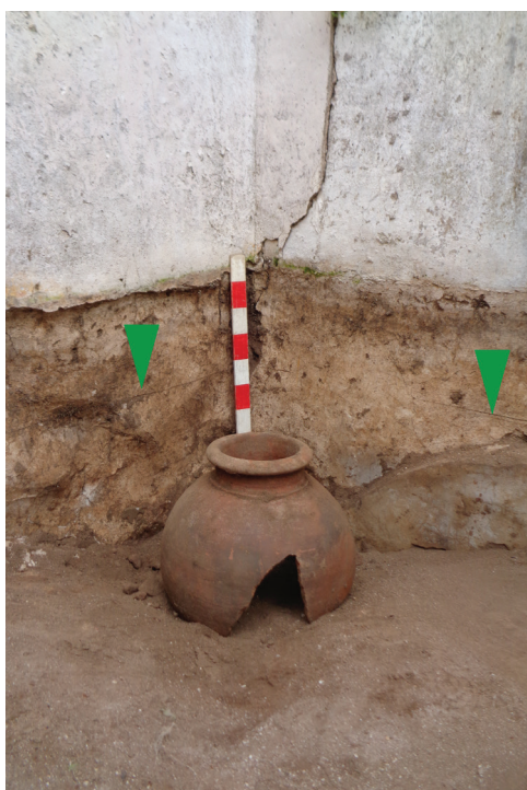
Figura 6.38 - Canto NE do Coro Alto, vendo-se a continuação do reboco caído para baixo da linha de cota do pavimento e, ainda in situ, um dos muitos fragmentos de recipientes que integravam as cargas das abóbadas. As setas verdes marcam uma suposta linha de nível. Maio de 2018.
