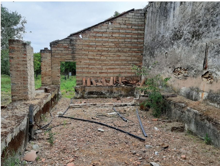
Figura 6.56 - Antigo tanque de lavagem do Convento do Bom Jesus, mais tarde reaproveitado como telheiro. O muro que se vê à direita é construção da primeira metade do século XX. Junho de 2020.
