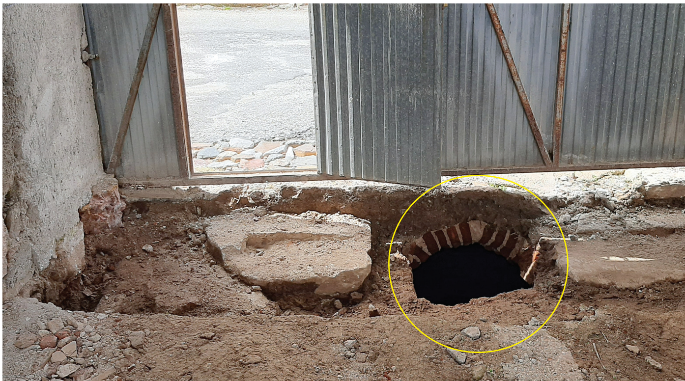
Figura 6.46 - A conduta de água que vinda da antiga Fonte Coberta, entrava no Convento pela Porta do Carro. Estruturada em tijolo burro, tem cerca de 90cm de altura por 45cm de largura. Nesta zona foi encontrada em parte assoreada por terras. Abril de 2021.
