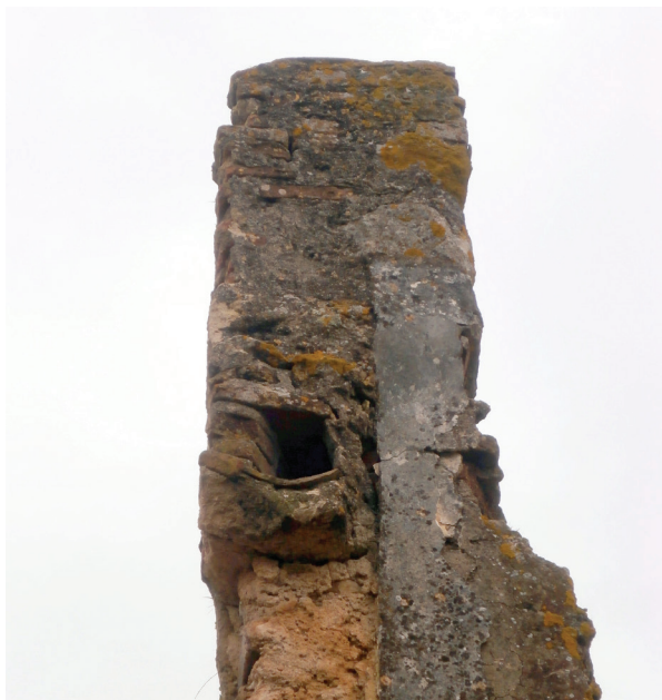
Figura 6.54 - Vestígios de uma conduta para águas sujas, numa das raras paredes sobreviventes do lado NO do complexo. Esta conduta poderá ter servido a zona das sentinas que estaria instalada na ala norte do Dormitório Velho . Janeiro de 2019.
