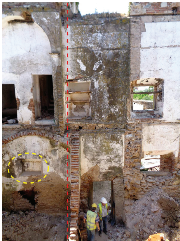
Figura 6.14 - A tracejado amarelo, a janela entaipada do alçado nascente do piso térreo da Torre da Prioresa. A linha vermelha assinala o limite da torre, que lhe fica à esquerda. Junho de 2018.
