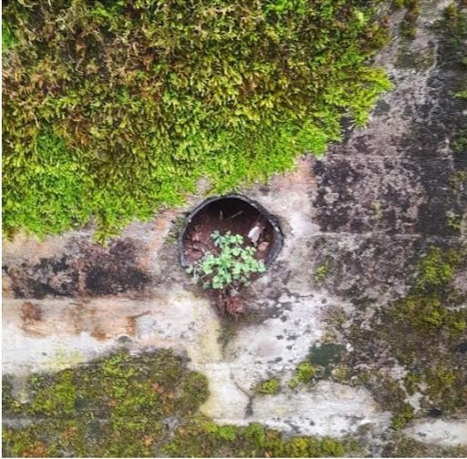
Figura 20 – Tubos de drenagem entupidos |
