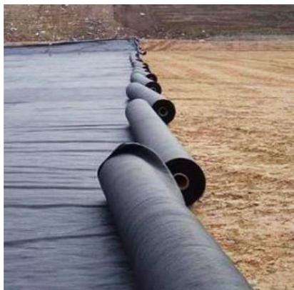
Figura 59 – Uso de manta geotêxtil não-tecido para proteção do solo |
