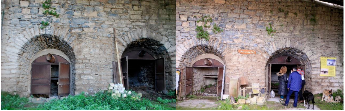
Image 28. Alves Cecilia, Zona de descarga de hornos , 2009. Photographie. Archives privées La Calera 1888. Image 29. Molina Luis, Descripción en los hornos de cal , 2018. Photographie. Archives privées du Luis Molina.
