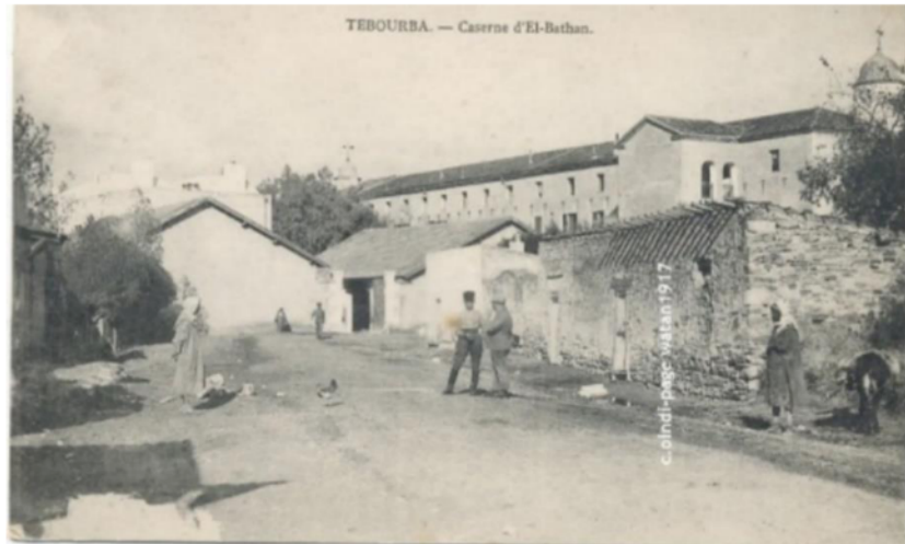
Figure 29: Caserne El-Battan en 1917 : l'ouest de la manufacture 179
