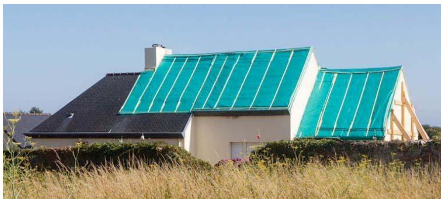
Figure 60: Exemple des bâches de toiture. 246
