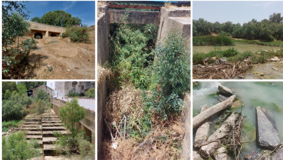
Figure 62: Etat du pont-barrage El-Battan. 253
