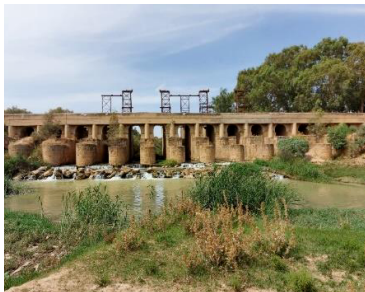
Figure 69: Vue du barrage
