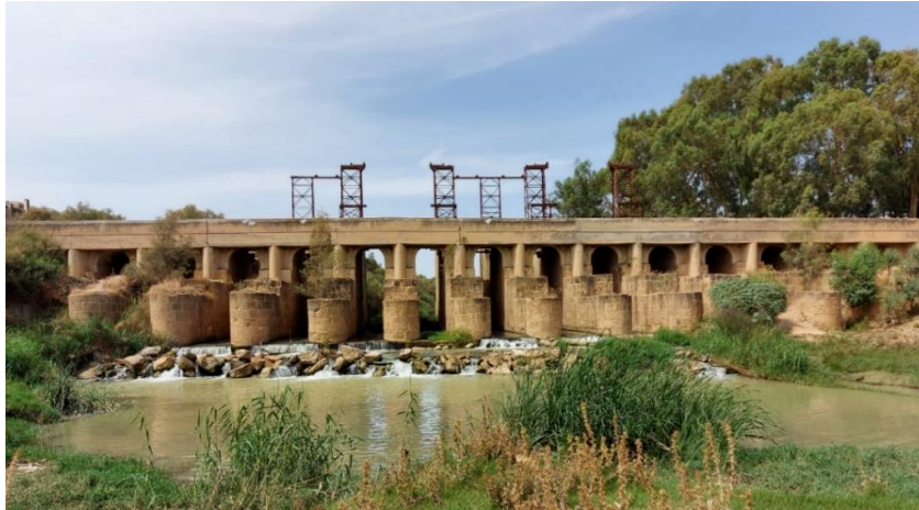
Figure 21: Le pont-barrage El-Battan. 100
