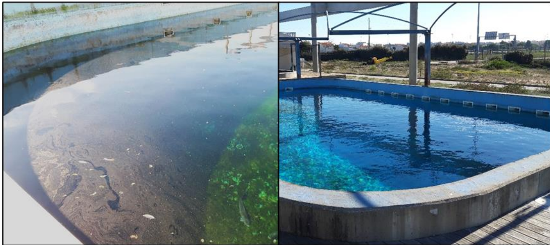
Figura 10 – Diferença entre tanque com má manutenção (à esquerda) e boa manutenção (à direita).
