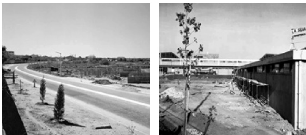
Figura 6 – Fase inicial de construção de estrutura pavilhonar, em 1969, da Escola Industrial e Comercial de Évora na zona este da cidade. Fonte: Arquivo Fotográfico da Câmara Municipal de Évora – DFT11518.
