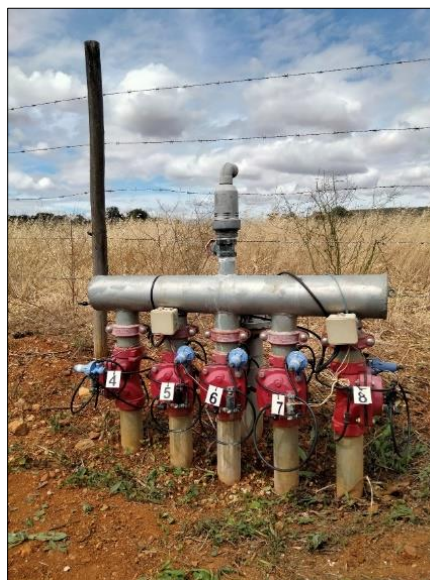
Figura 18. Válvulas de cada um dos setores de rega
