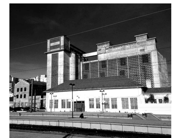
Fotografia da Fábrica Atualmente - Alçado Sul Foto captada pelo autor
