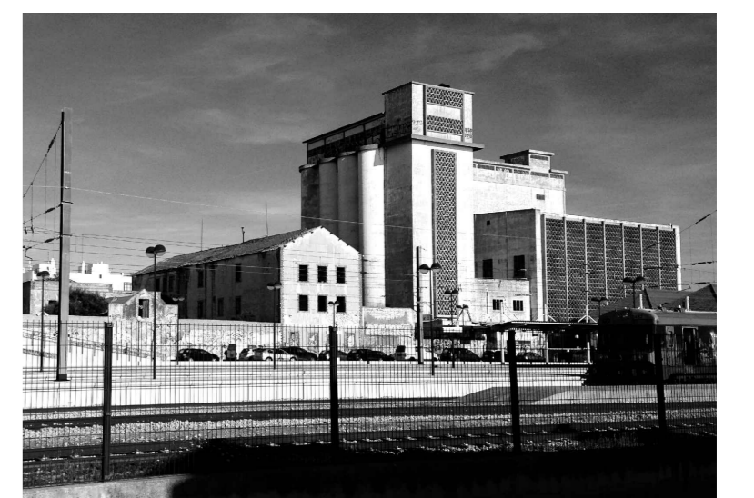
Fotografia da Fábrica Atualmente - Alçado Sul Foto captada pelo autor
