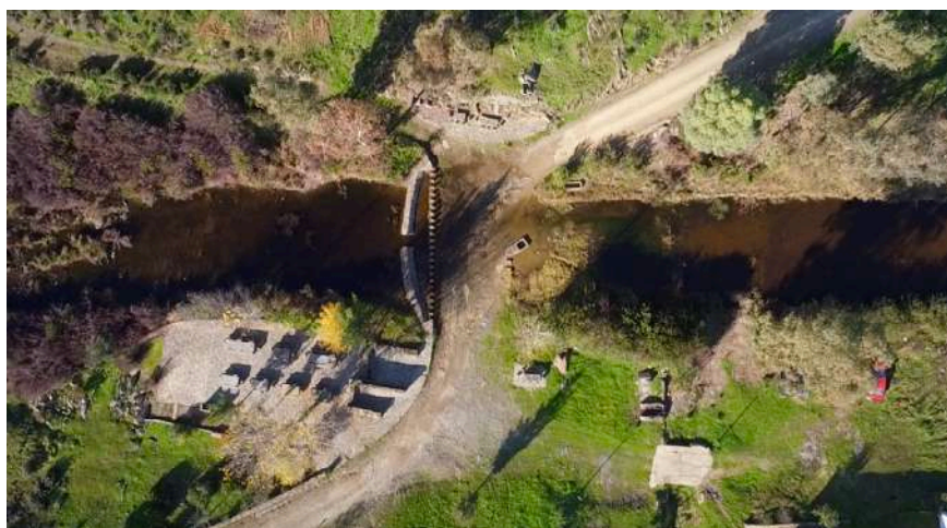
Fig. 58. Vista de topo: constelação de muros e plataformas de pedra, dezembro, 2018.
