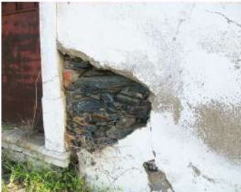
Fig. 71. Sistema construtivo: constituição das paredes e cobertura, fevereiro, 2015. ▼
