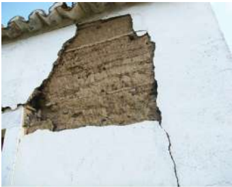
Fig. 70. Sistema construtivo: constituição das paredes, fevereiro 2015. ▼
