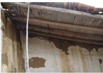
Fig. 71. Sistema construtivo: constituição das paredes e cobertura, fevereiro, 2015. ▼
