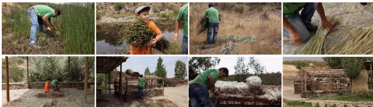
Fig. 63. O processo de preparação, montagem e construção das estruturas temporárias, maio, 2015.
