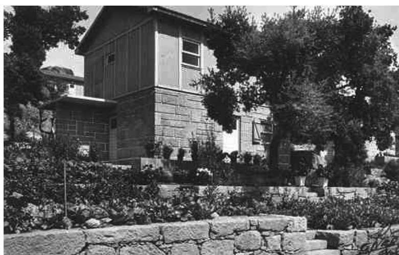
Figura 5. Vista exterior de uma Casa Temporária do Pessoal Auxiliar (PA) de dois pisos, construída por painéis pré-fabricados de madeira no piso superior e alvenaria no piso térreo. Data: 17.08.1955. Fonte: Arquivo EDP.
