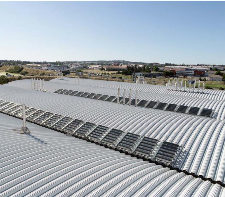
Fig.2. Atividades de desenvolvimento e demonstração da CER-UÉ no domínio do calor de processo solar: coletor solar quase-estacionário (SHIP).
