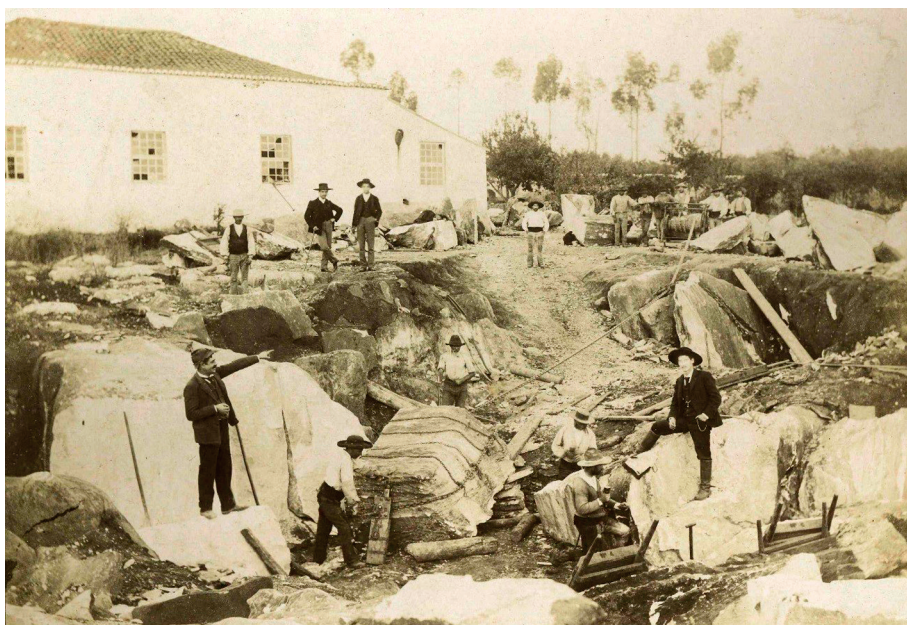
Figura 7: Pedreira da Cerca de Santo António (Estremoz) em laboração em Setembro de 1901, mostrando as técnicas rudimentares utilizadas na exploração de mármore início do século XX (Foto de Ernesto Vieira; Fotografia cedida pela Biblioteca Municipal de Estremoz/ Arquivo Fotográfico).
