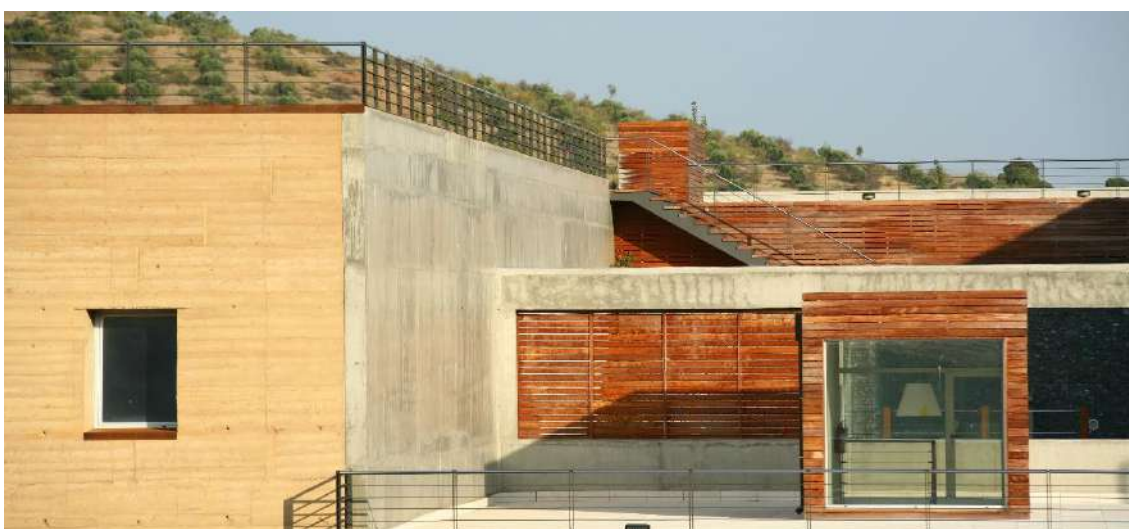
Fig. 103 – Relação entre materiais. Taipa, Madeira e Betão. (Cortesia de Carlos Vitorino. 8 de janeiro, 2020).
