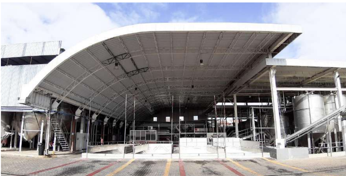
Fig. 45 – Estrutura metálica interior/externo. (Foto do autor. 6 de novembro, 2019).
