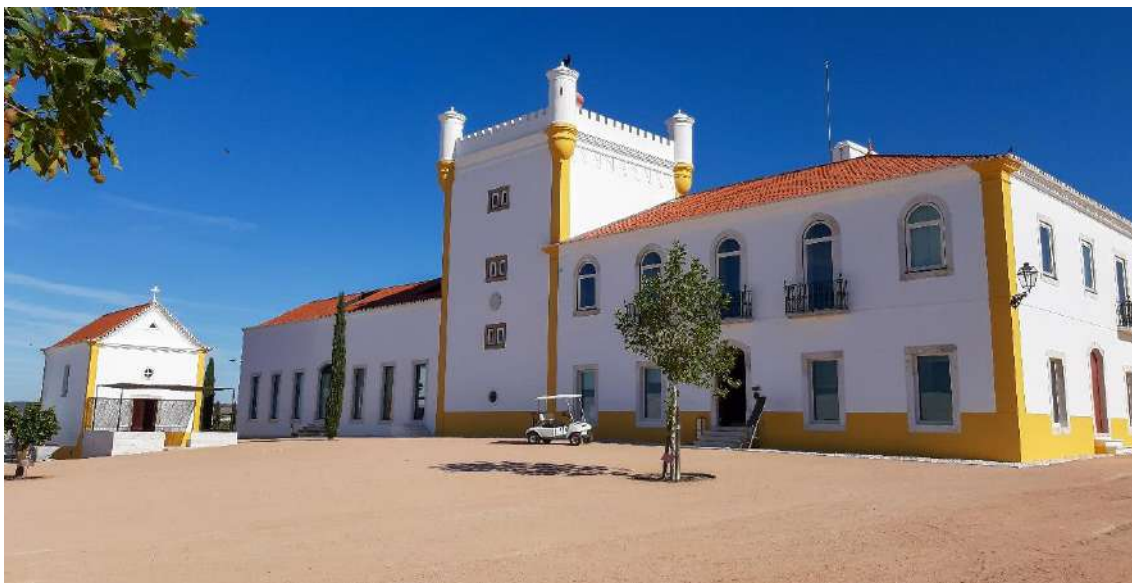
Fig. 138 - Casa-mãe e capela em evidência. (Foto do autor.8 de outubro, 2019).
