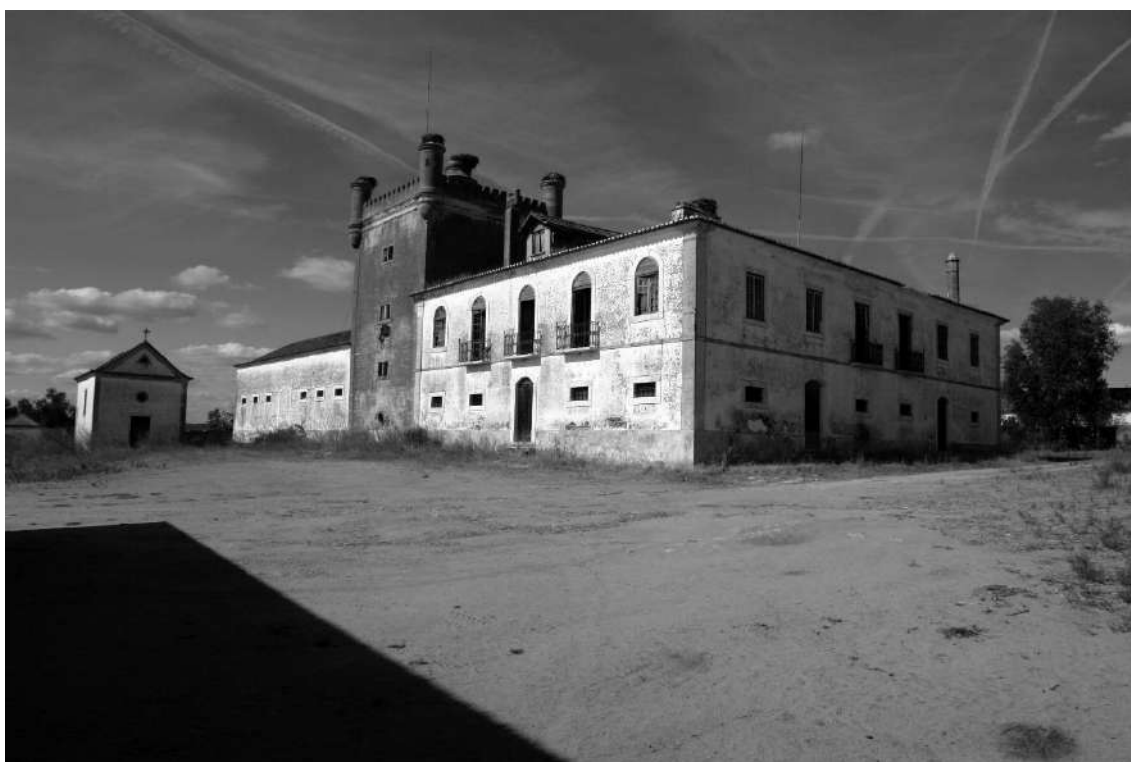
Fig. 136 - Estado de decadência antes da recuperação do conjunto. (Cortesia de João Mendes Ribeiro, 2019).
