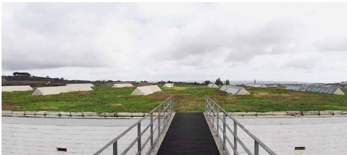
Fig. 57 – Cobertura ajardinada e claraboias em destaque. (Foto do autor. 6 de novembro, 2019).
