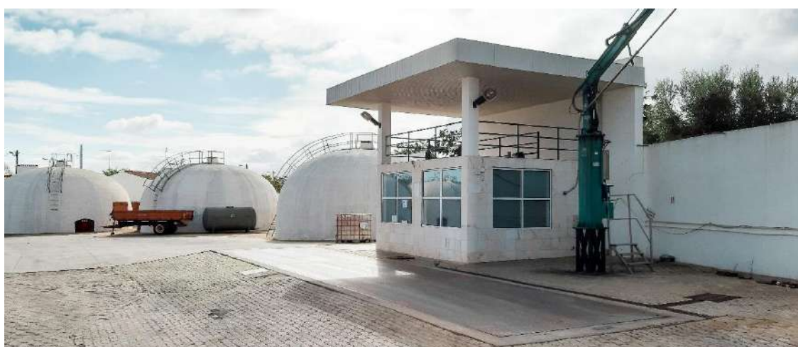
Fig. 32 – Edifício de controlo de receção e pesagem de uva. (Foto do autor. 6 de novembro, 2019).
