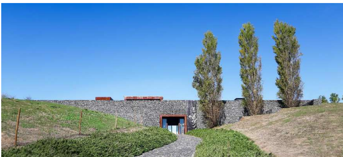
Fig. 94 - Fachada em gabião. (Foto do autor. 25 de outubro, 2019).
