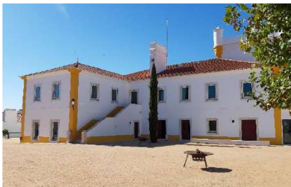
Fig. 150 - Estado após-restauro. (Foto do autor. 8 de outubro, 2019).
