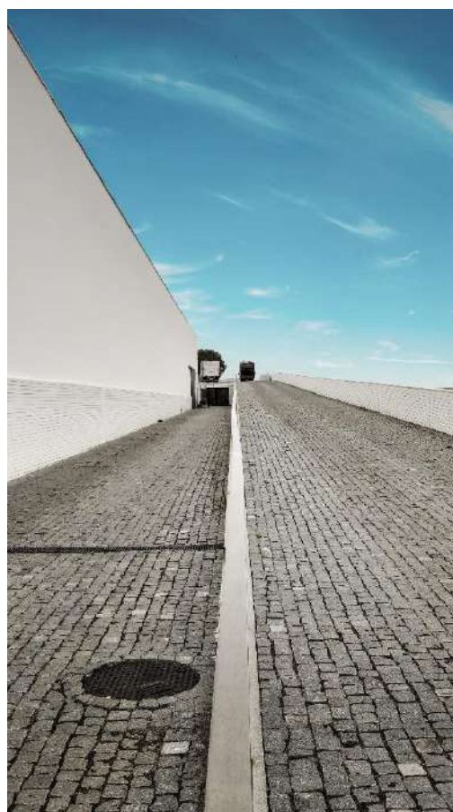
Fig. 110 - Rampa de acesso à zona cargas/descargas (foto do autor. 17 de outubro 2019).
