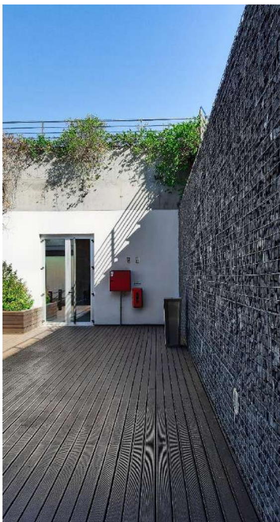
Fig. 98 - Parede em gabião vista do interior do projeto. (Foto do autor. 25 de outubro, 2019).
