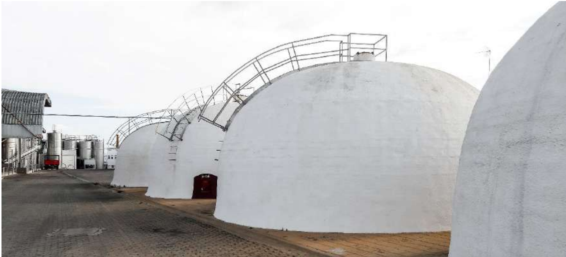
Fig. 46 – Estruturas em betão de grande espessura para fermentação do produto. (Foto do autor. 6 de novembro, 2019).
