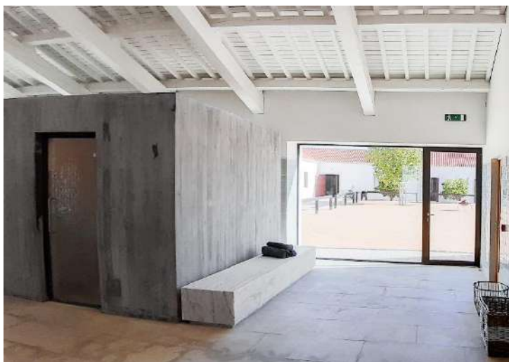
Fig. 171 - Espaço da sauna em betão aparente. (Foto do autor. 8 de outubro, 2019).
