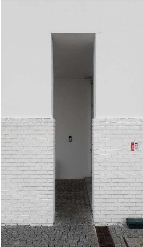
Fig. 128 - Embasamento em alvenaria caiada. (Foto de autor. 17 de outubro, 2019).
