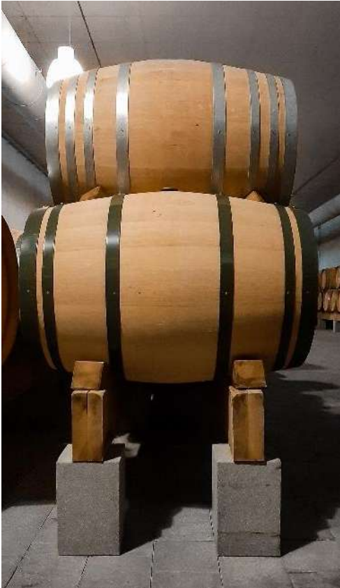
Fig. 115 - Suporte de barricas composto por madeira e betão. (Foto do autor. 17 de outubro 2019).
