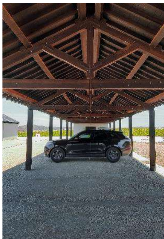
Fig. 164 - Estrutura do estacionamento. (Foto do autor. 8 de outubro, 2019).
