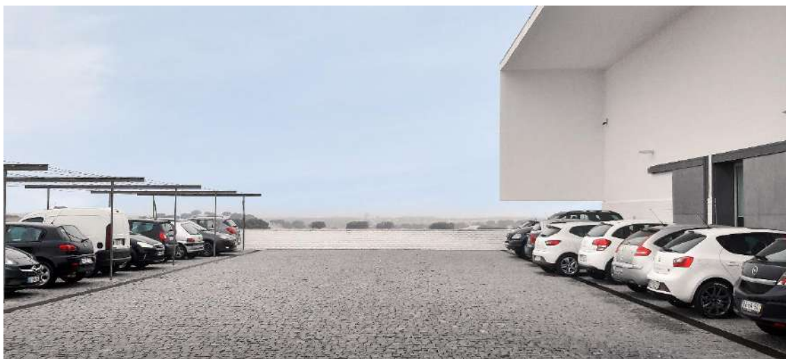
Fig. 123 - Estacionamento e acesso das descargas da loja. (foto do autor. 17 de outubro, 2019).
