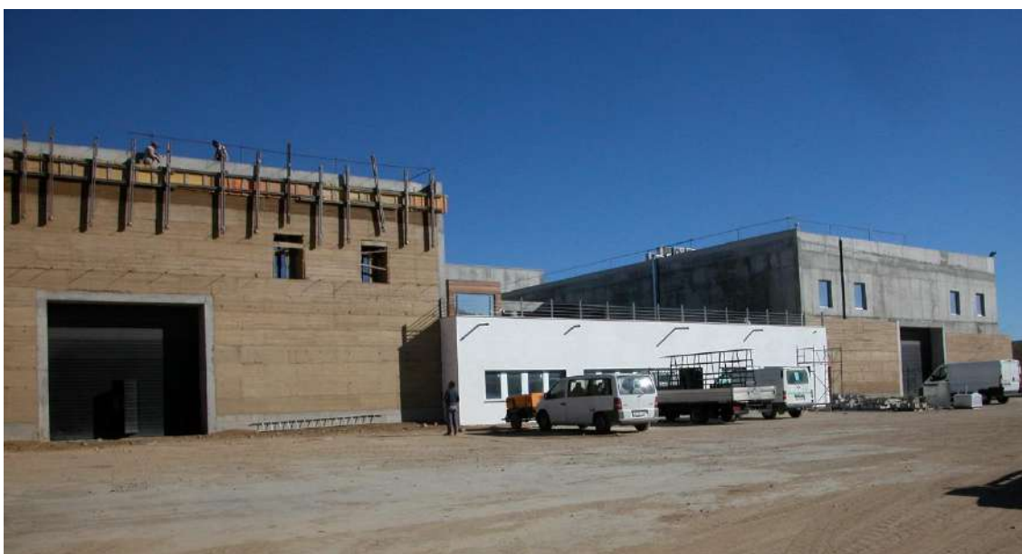
Fig. 102 - Aplicação da taipa durante a construção. (Cortesia de Carlos Vitorino. 8 de janeiro, 2020).
