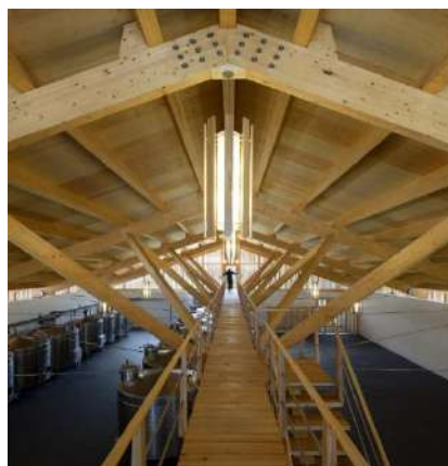
Fig. 29 - Sala de depósitos e passadiço elevado. (Fernando Guerra | FG + SG).
