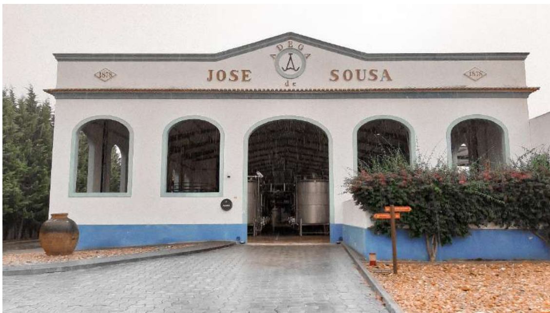
Fig. 65 - Entrada do edifício recente. (Foto do autor. 17 de outubro 2019).
