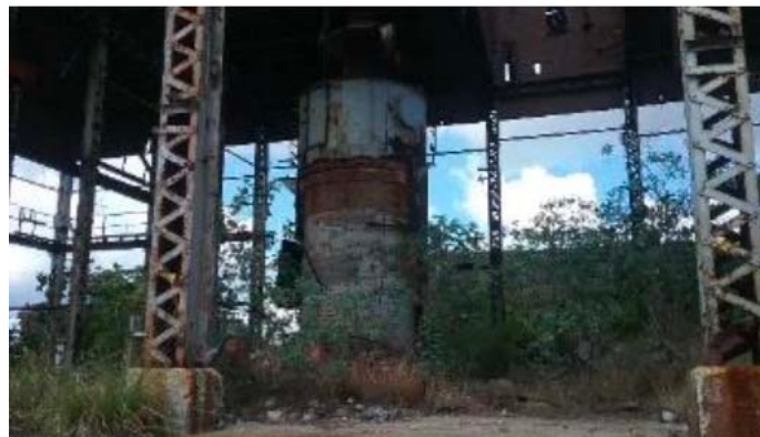
Fig. 14 Maison du générateur de gaz Source : Archive de Teresa Bilbao
