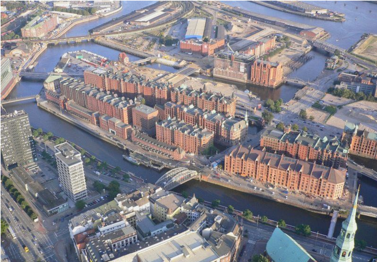
Fig. 20 Speicherstadt, un quartier d'entrepôts à Hambourg Source : https://destinoinfinito.com/speicherstadt-un-distrito-de-almacenes-en-hamburgo/
