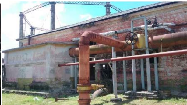
Fig. 32 Bâtiment du Gouverneur et compteur de sortie de gaz Source : Archive de Teresa Bilbao
