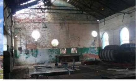
Fig. 27 Bâtiment qui occupait la charpenterie et une section de la purification. Source : Archive de Teresa Bilbao
