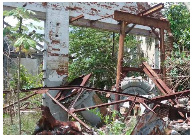
Fig. 18 Maison des ventilateurs
