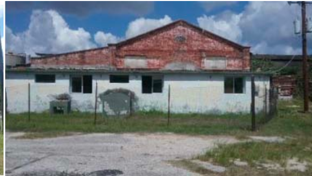
Fig. 10 Usine à gaz, département des générateurs Source : Archive de Teresa Bilbao
