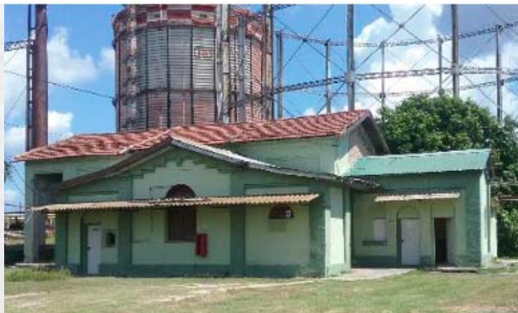
Fig. 29 Bâtiment dans lequel le bureau et les compteurs de gaz ont été installés Source : Archive de Teresa Bilbao
