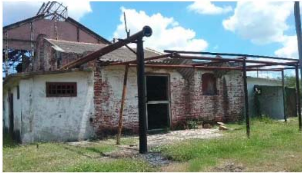
Fig. 9 Usine à gaz, département des générateurs Source : Archive de Teresa Bilbao
