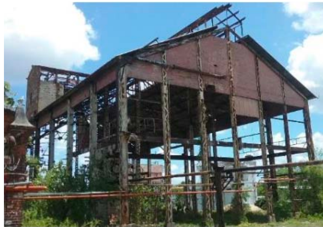
Fig. 13 Maison du générateur de gaz Source : Archive de Teresa Bilbao
