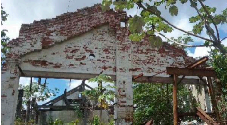
Fig. 19 Maison des ventilateurs Source : Archive de Teresa Bilbao
