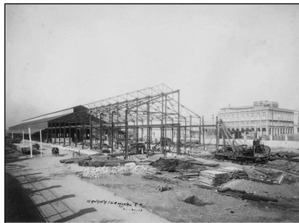
Figure 3.12. Construction des entrepôts et des quais de la Gare Centrale sur les terrains de l'ancien Arsenal de La Havane, cour des voies (02-02-1911) photographie, signée par *Havana Terminal Co.* Source : Photothèque Historique du Bureau de l'Historien de la Ville
