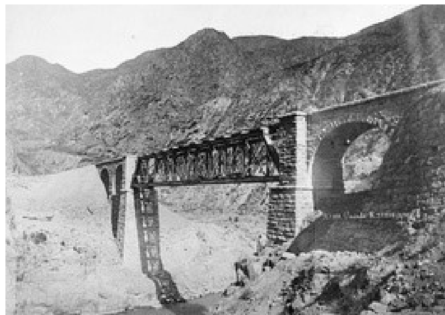
Ponte de 45 metros de largura (Km 47 de Mendoza), 1907.
