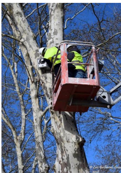
Figura 6. Instalação de protótipo para dissuasão de aves de rapina noturnas.
