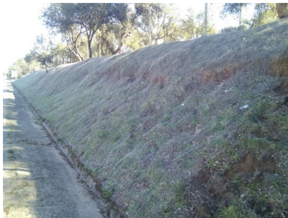
Figura 5. Rede para evitar colonização de coelhos (Lagomorpha) nas bermas das rodovias.
