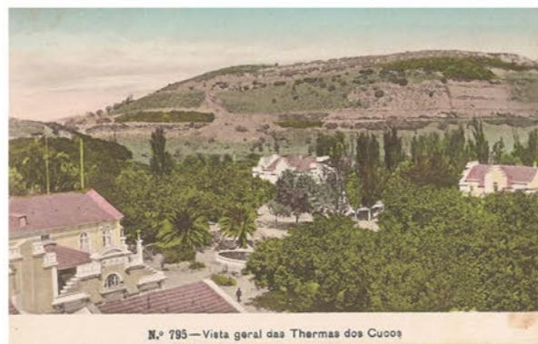
fig.074_ fig.070 à 074 | Conjunto de postais ilustrativos da vista geral do Parque Verde
