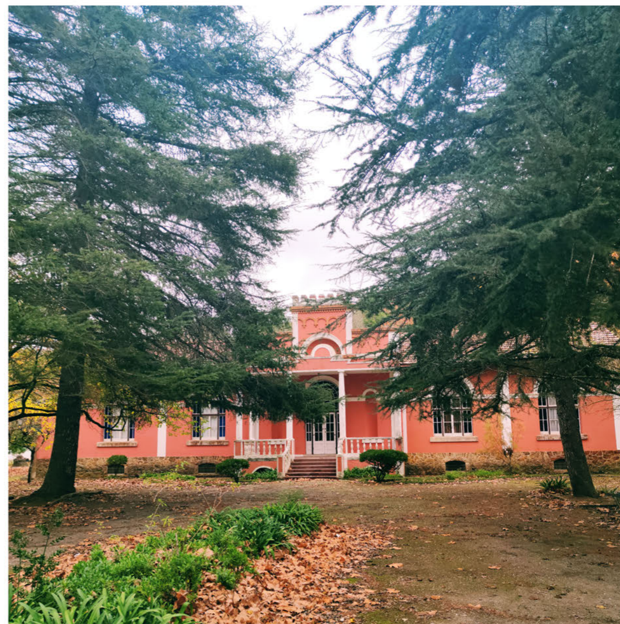
fig.048 | Vista geral do Casino
