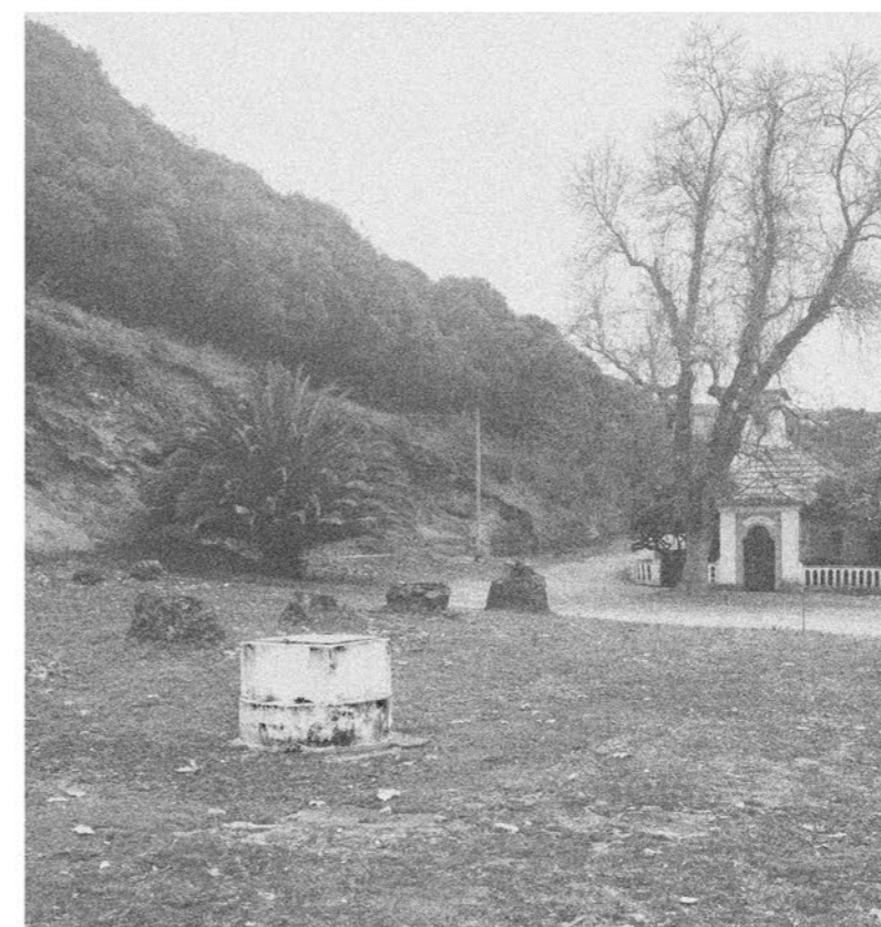
fig.017 | Vista Geral à superfície do Furo da Nova Captação
