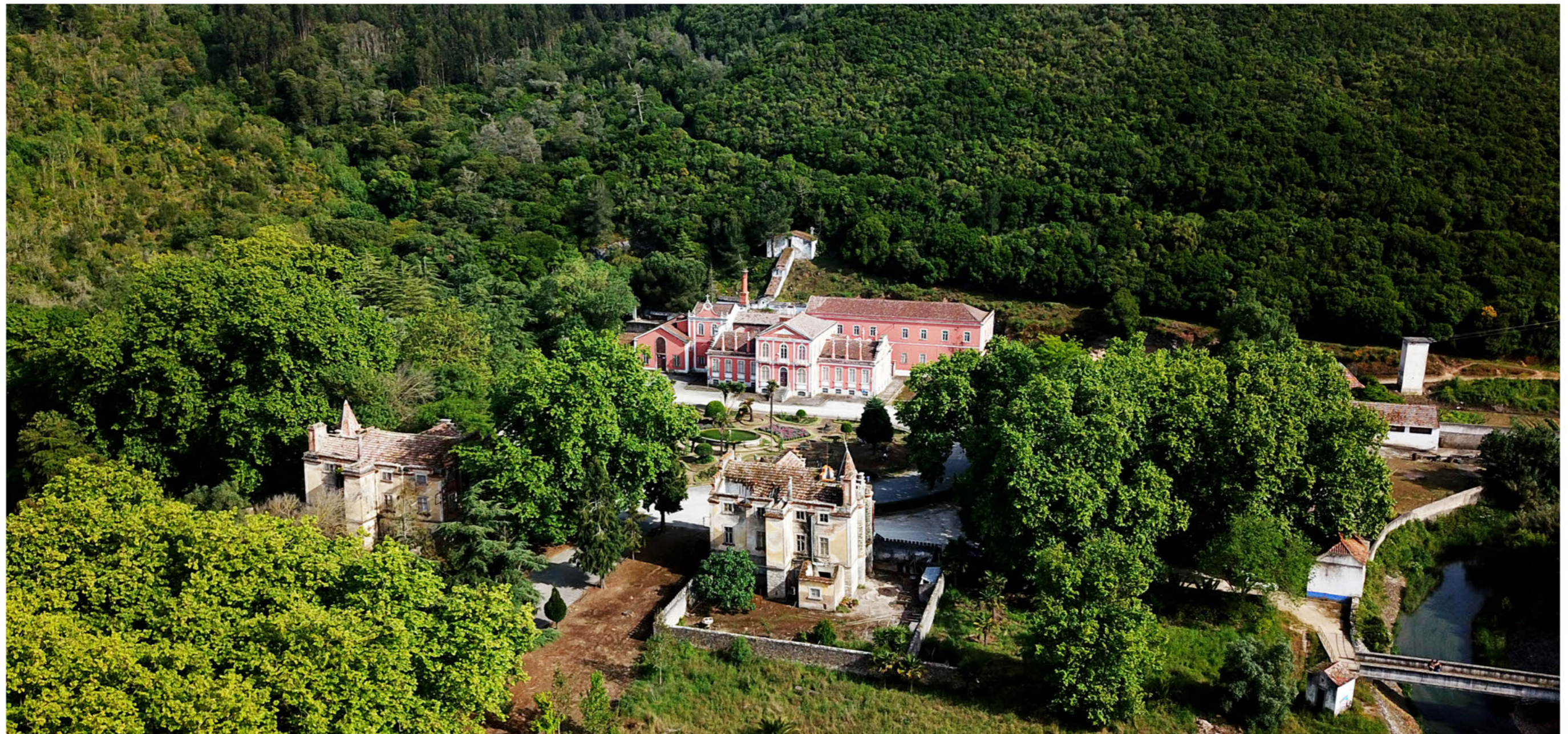
fig.023 | Fotografia Aérea _ Vista geral do Parque das Termas do Vale dos Cucos
