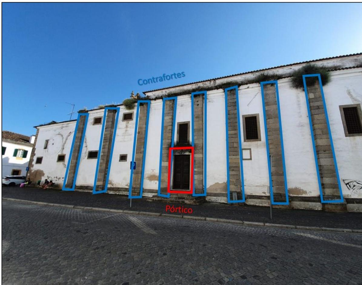
**Fig. 30** Contrafortes e Pórtico (no século XX a parte mais baixa da fachada, à esquerda, foi adaptada às novas funções, daí não podemos determinar bem a dimensão do parlatório, ou se haveria dois, e mesmo da portaria; aliás, há móveis que cortam a divisão).
