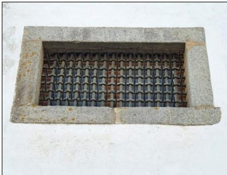
**Fig. 2** Grade com espigões na janela do Parlatório interno.
