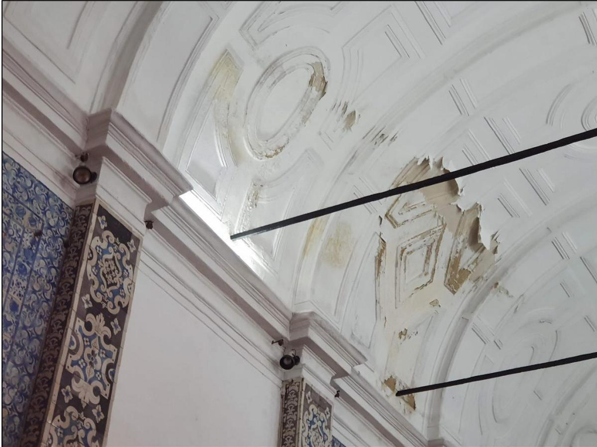
**Fig. 77** Destacamento de pintura de abóbada da igreja.
