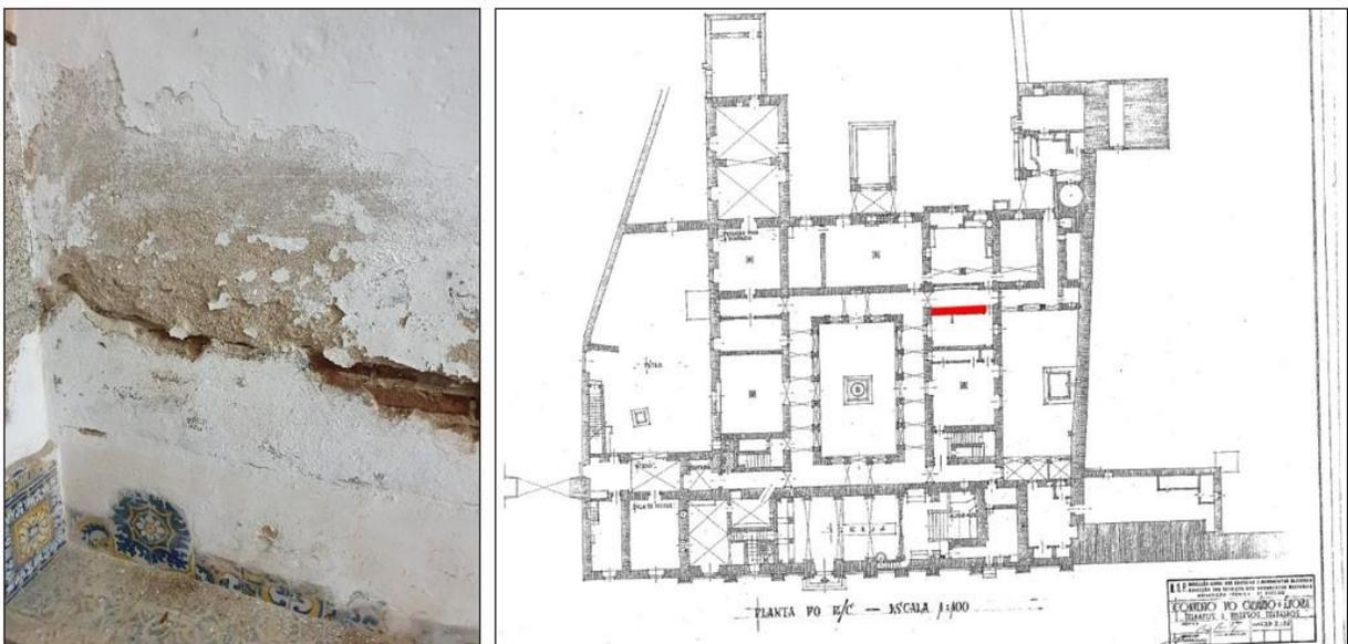
**Fig. 12** Desagregação do reboco na parede da Antessala do Refeitório.
