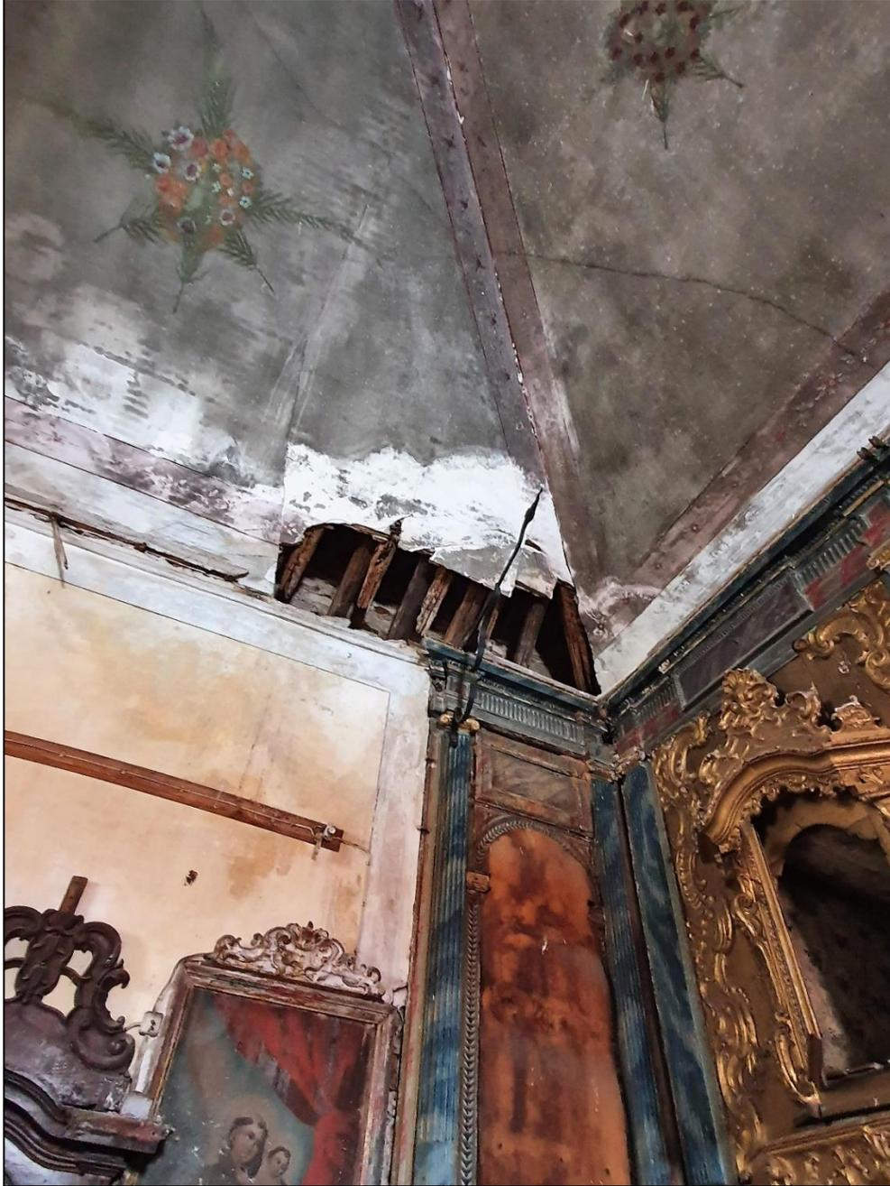
**Fig. 80** Colapso de tábuas no teto de caixotões do Coro alto (madeira e estuque).
