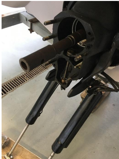
Figura 3.41: Alinhamento do eixo do motor
