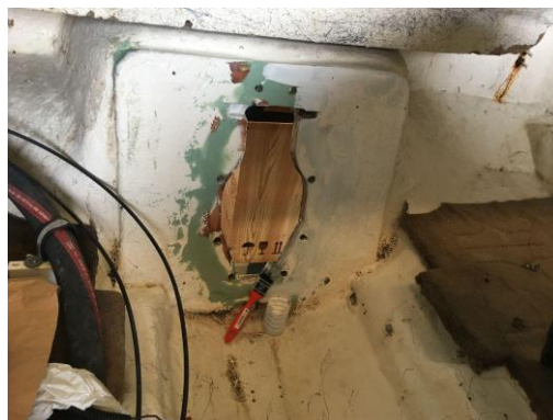
Figura 3.51: Aplicação de betume em zonas do painel de popa do compartimento do motor da embarcação Rinker 182
