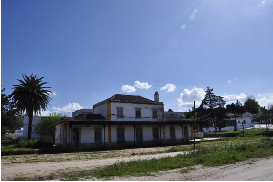
Figura 1. Aspeto da estação antes das obras de requalificação.
