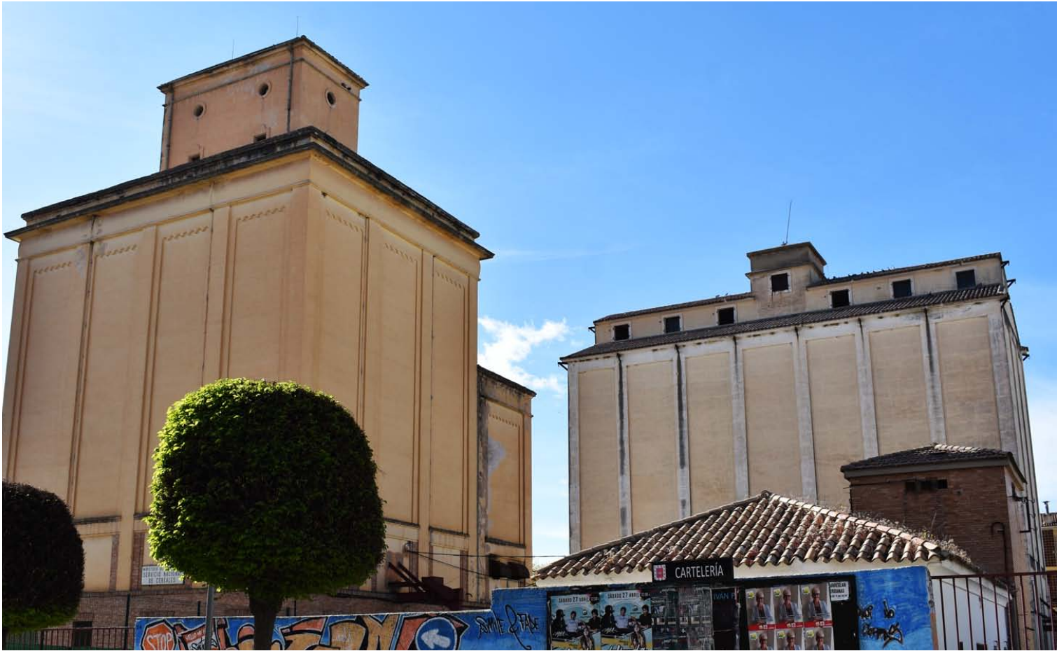
Úbeda grain silo. 2019.
