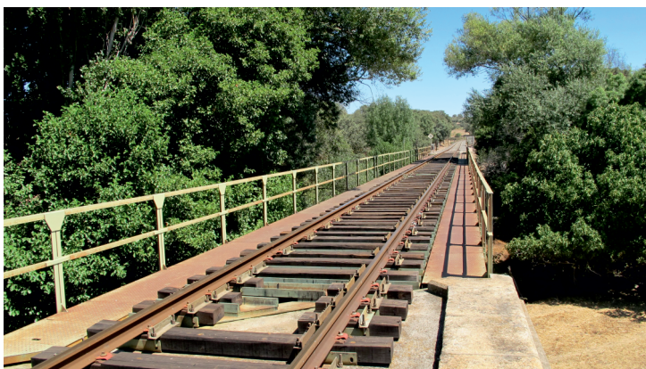
Ponte Ferroviária internacional sobre o Rio Sever
