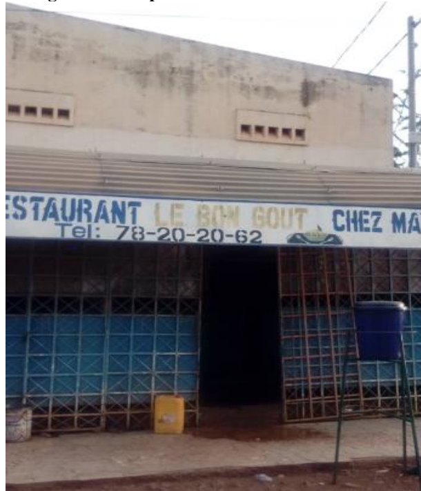
Figure 5 : Vue partielle de l'ancien ciné SIBIRI
