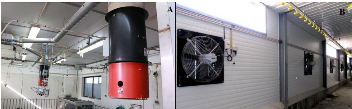
Figura 1 - A: extratores verticais; B: ventiladores transversais (Fonte: Material didático ERU10432)
