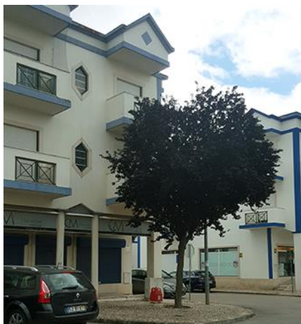
Figura 19 - Árvore próxima do edifício.
