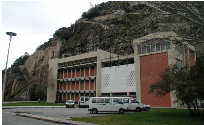
16.Barrocal do Douro Barragem edifício de controlo
