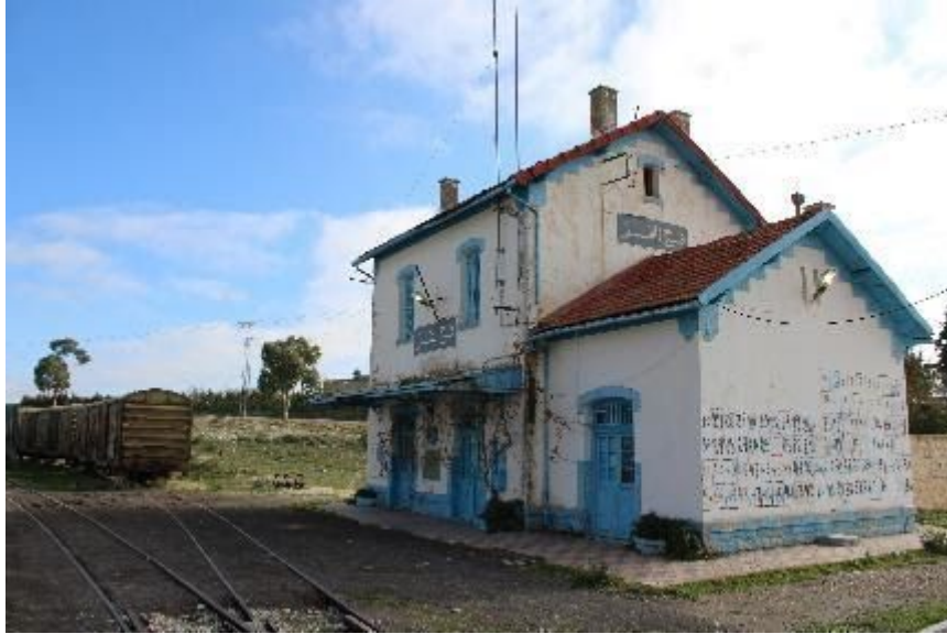
Gare de faj Tamr/ janvier 2020/ photo auteur
