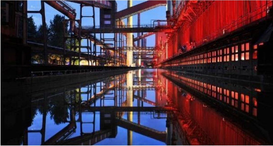
L'installation « Monochromatique Red and Blue », de Jonathan Speirs et Mark Major, transforme les installations de cokéfaction en une œuvre d'art qui s'illumine tous les soirs. – © Frank Vinken / Zollverein Foundation
