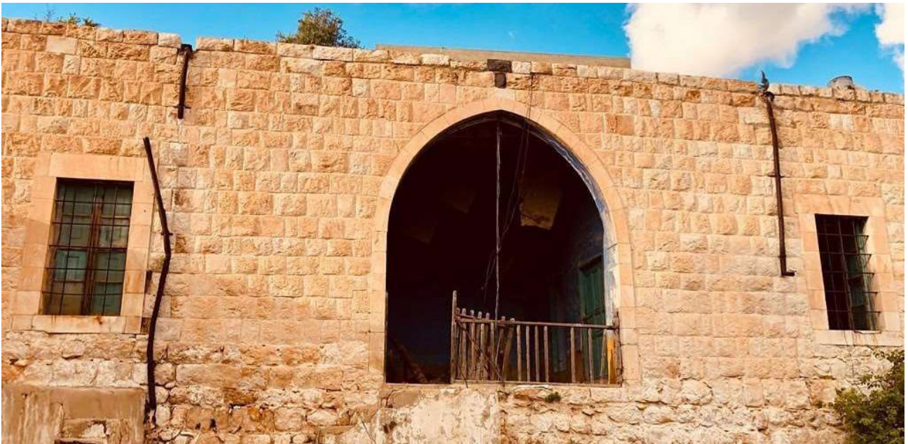
Fig. A-37 : La façade sur de la maison de Michel Khalaf à Ras Baalbeck Source : Photo Tia Wakim
