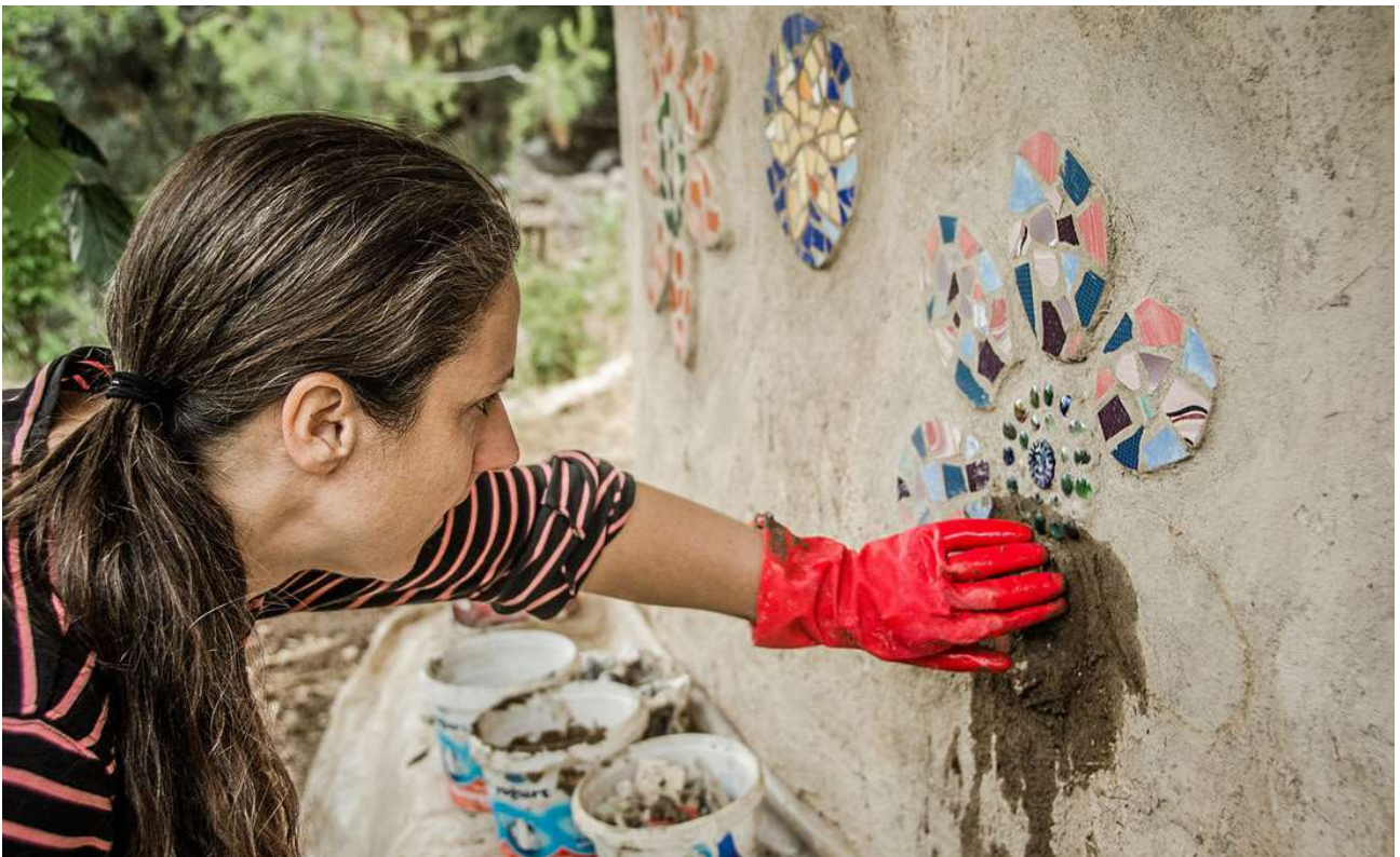
Fig. A-13 : La décoration des facade de l'Earthbag house. Photo Atulya K Bingham Source : Le blog - toitsalternatifs.fr
