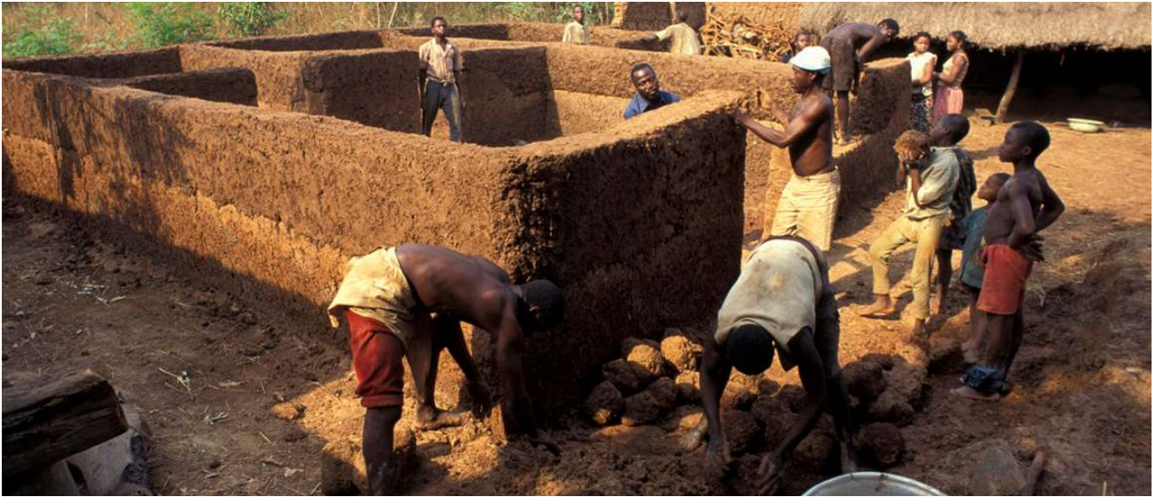
Fig. A-5 : Construction d'une maison en bauge au Bénin Photo Thierry Joffroy Source : Bérengère Perello. Pisé or not pisé ? ArchéOrient - Le Blog
