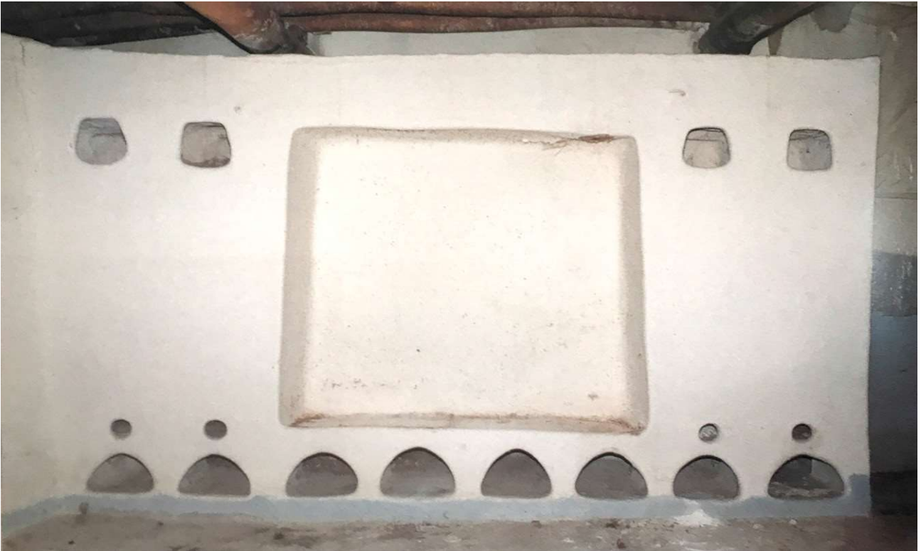
Fig. A-36 : Une mur de partition intérieur, doté d'un youk et de silos à graines.
