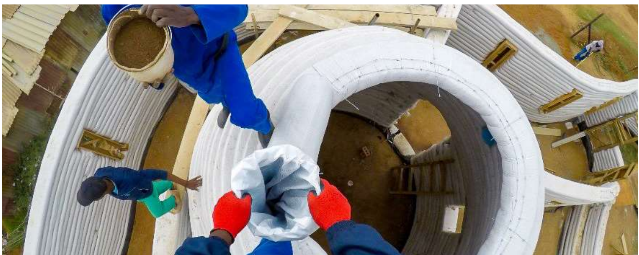
Fig. A-12 : Chantier du Langbos Children's Centre Source : Le blog – Archdaily
