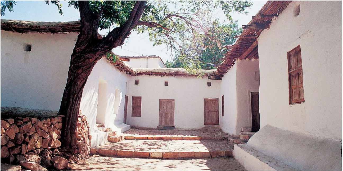
Fig. A-41: La Maison de Terbol à la fin des travaux
