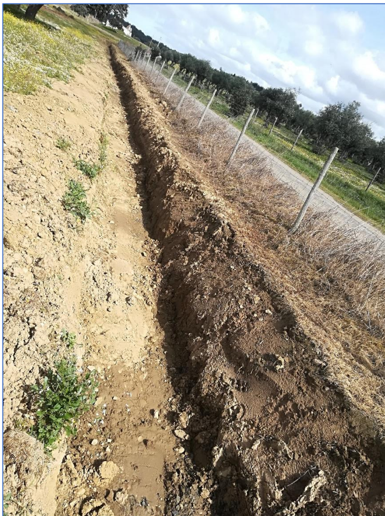
Figura 23. Vala aberta no terreno de depósito da terra
