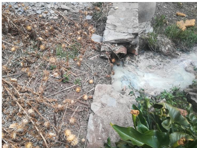
Figura 60-Estrutura da antiga ETAR que verte águas residuais diretamente para a ribeira de S. de Rio de Moinhos
