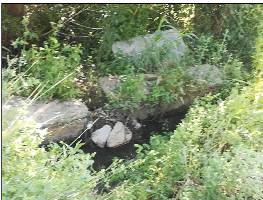
Figura 16. Parte da estrutura da levada
