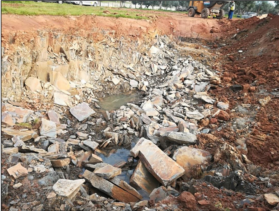
Figura 21. Abertura da vala para implantação da lagoa anaeróbica 2.
