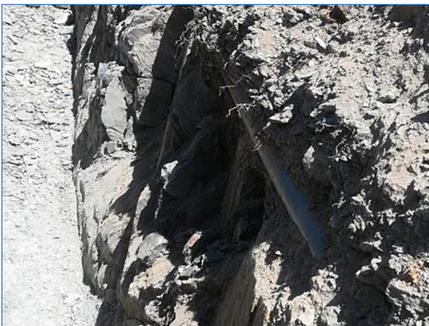
Figura 26. Tubo de transporte de água pública
