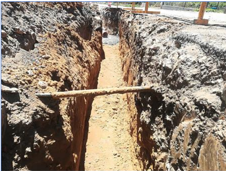
Figura 25. Tubo de água no interior da vala que liga um terreno a outro.
