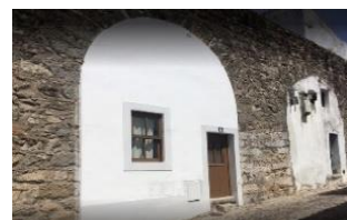
Figura 35: Casa no Aqueduto da Água de Prata.
