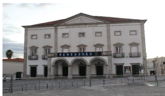
Figura 28: Fachada frontal do Teatro Garcia de Resende.
