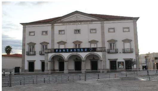
Figura 36: Fachada frontal do Teatro Garcia de Resende.
