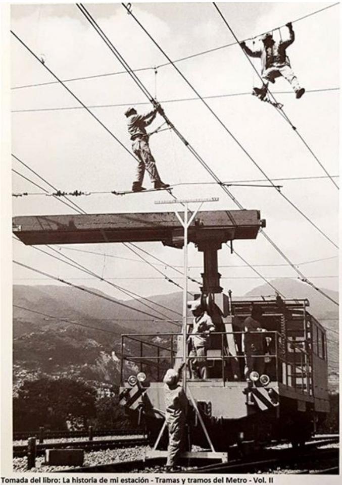
Installation de la caténaire sur la ligne A pendant le processus de construction du Métro. Source : Extrait du livre *L'histoire de ma station : Trames et tronçons du métro*, vol. II.
