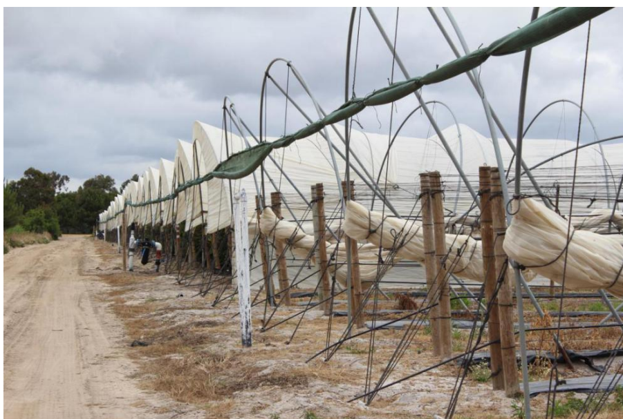
Figura 25. Estufas em construção, Odeceixe. Lília Fidalgo, 2018
